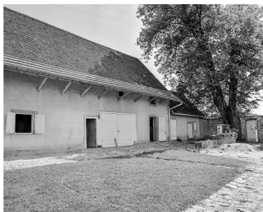
Ferme n° 16 : façade antérieure, partie droite. Phot. Dominique Dominguez IVR43_19773900092X
