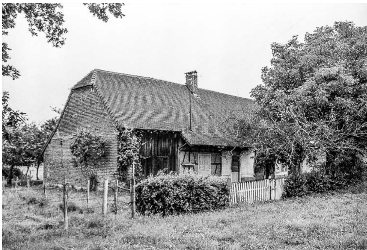
Ferme cadastrée 1969 AE 43 : façade antérieure.
