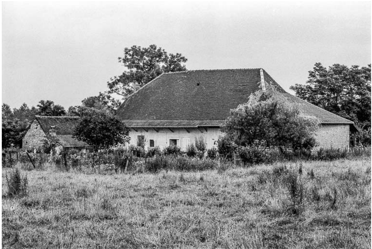
Ferme cadastrée 1969 AB 106-107 : façade antérieure
