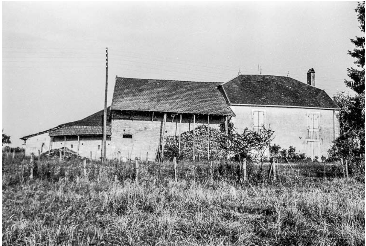
Ferme cadastrée 1969 AD 171-172 : façade postérieure.
