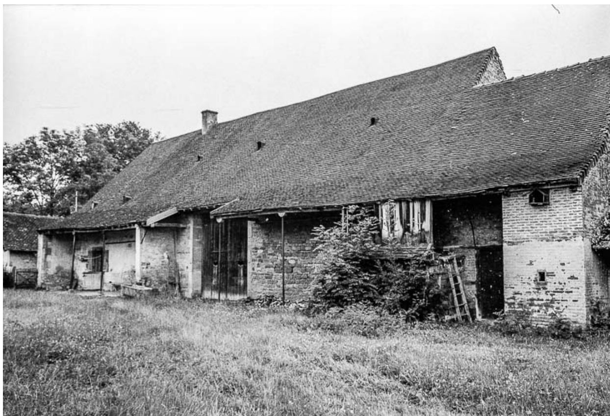
ferme cadastrée 1969 AB 111-112 : façade antérieure.
