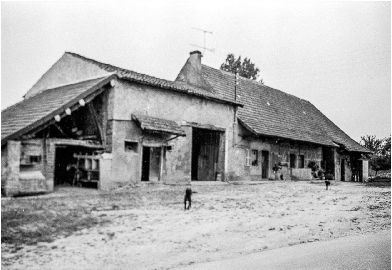
Ferme cadastrée 1969 AM 8 : façade antérieure.
