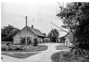
Ferme cadastrée 1969 AC 183 : vue d'ensemble. Phot. Guy Forestier IVR43_19753900283Z
