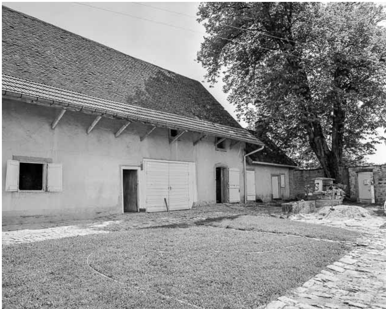
Ferme n° 16 : façade antérieure, partie droite.
