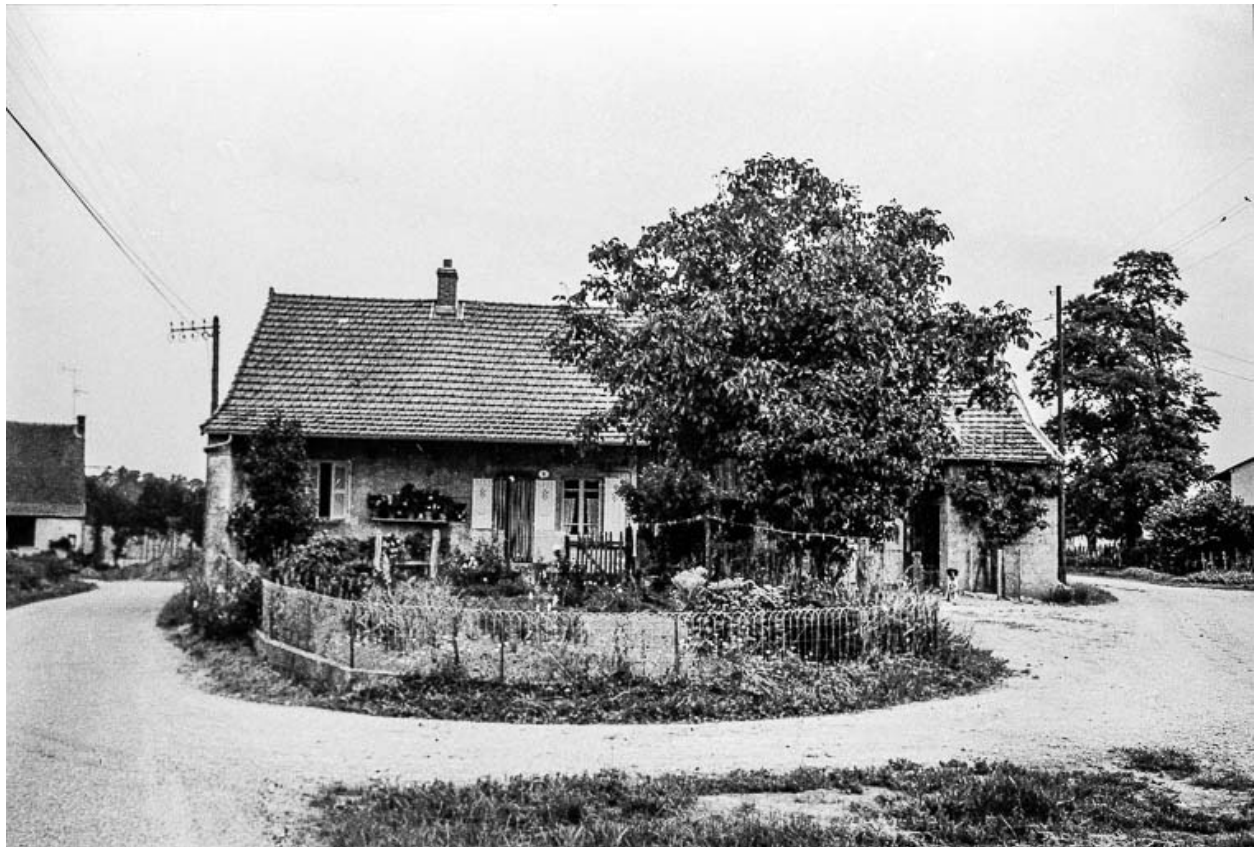
Ferme cadastrée 1969 AD 96 : façade antérieure.
