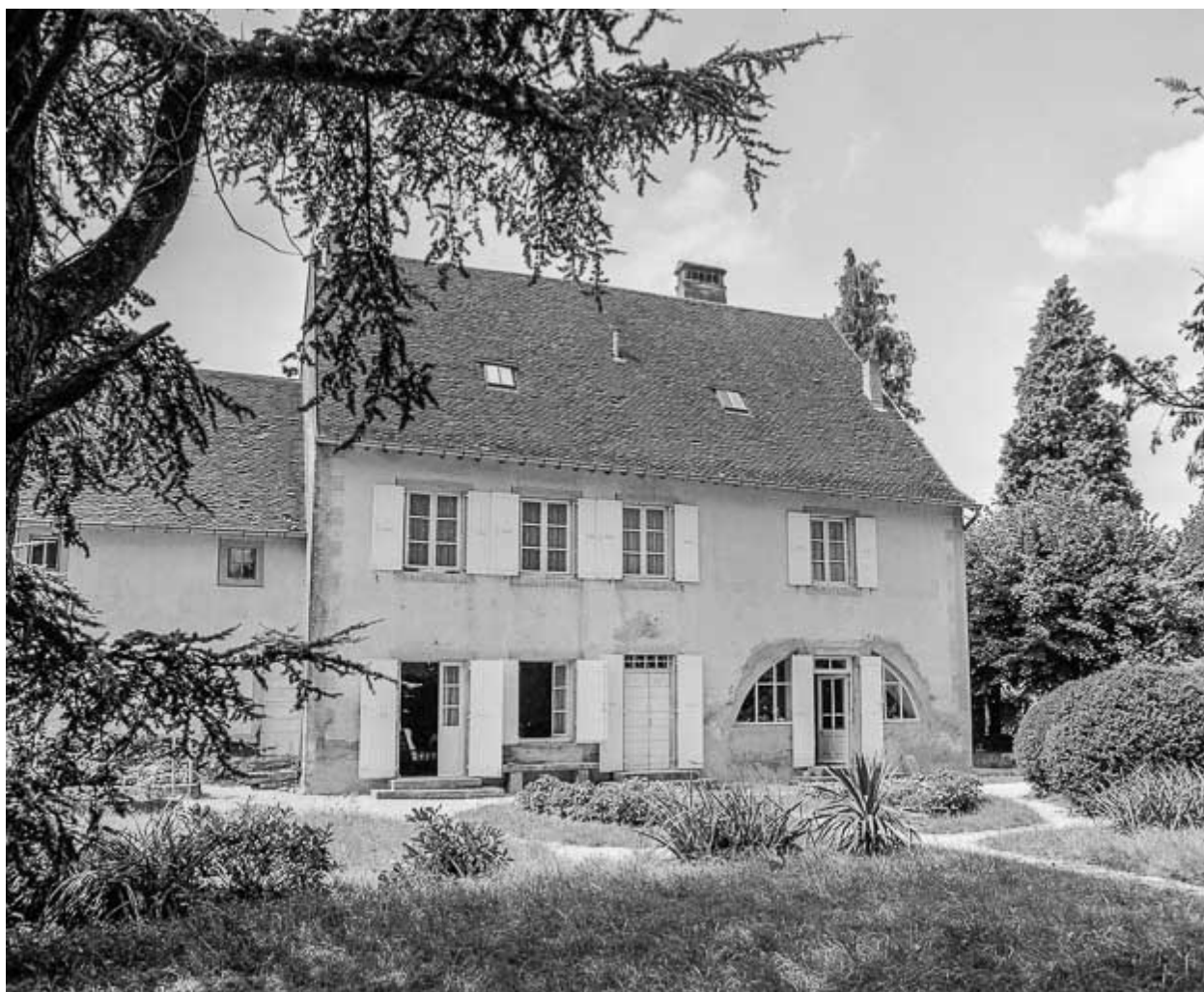
Ferme n° 16 : façade postérieure, partie gauche.
