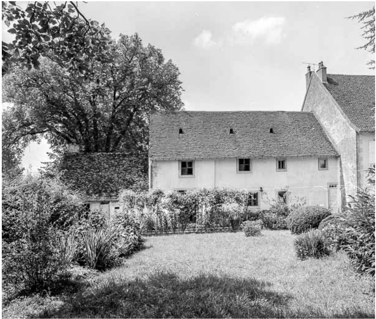
Ferme n° 16 : façade postérieure, partie droite.
