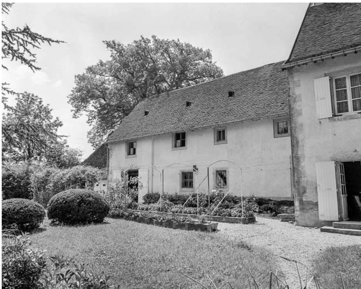
Ferme n° 16 : façade postérieure.
