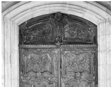
Détail de la première porte d'entrée. Phot. Yves Sancey IVR43_19822500029X
