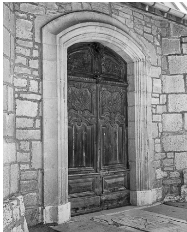
Vue d'ensemble de la première porte d'entrée. Phot. Yves Sancey IVR43_19822500028X
