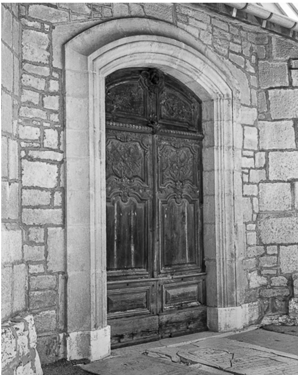
Vue d'ensemble de la première porte d'entrée.
