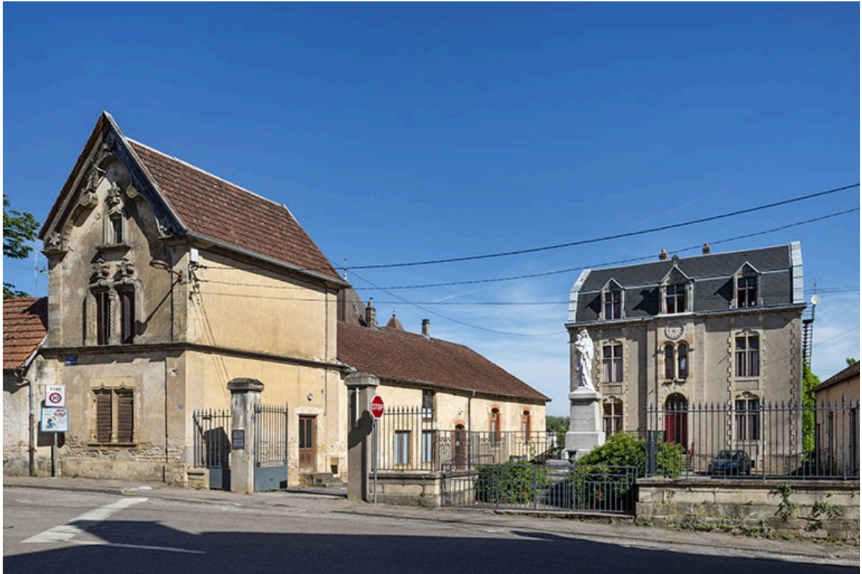
L'aile gauche et le bâtiment central.
