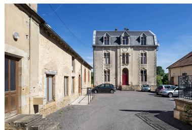
La cour et le bâtiment principal. Phot. Jérôme Mongreville IVR43_20217000408NUC4A
