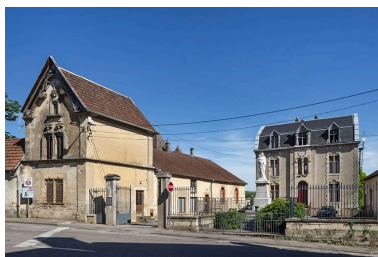
L'aile gauche et le bâtiment central. Phot. Jérôme Mongreville IVR43_20217000400NUC4A
