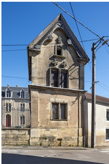
Le pignon de l'aile droite. Phot. Jérôme Mongreville IVR43_20217000399NUC4A
