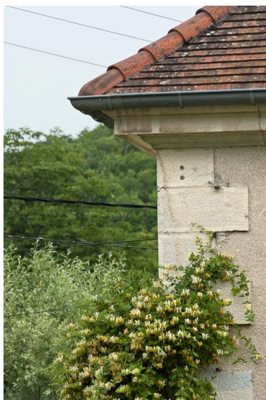
Détails de matériaux de la maison éclusière : corniche et chaîne d'angle. Phot. Pierre-Marie Barbe-Richaud IVR26_20112103549NUC2A
