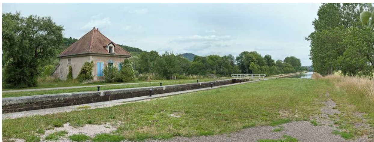
Vue d'ensemble du site d'écluse.
