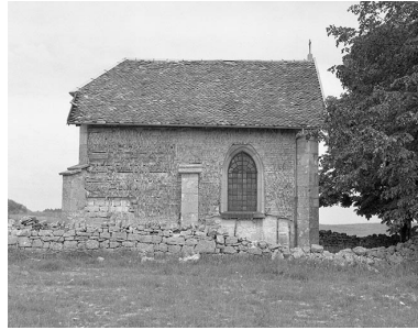
Façade latérale nord. Phot. Yves Sancey IVR43_19752500317X
