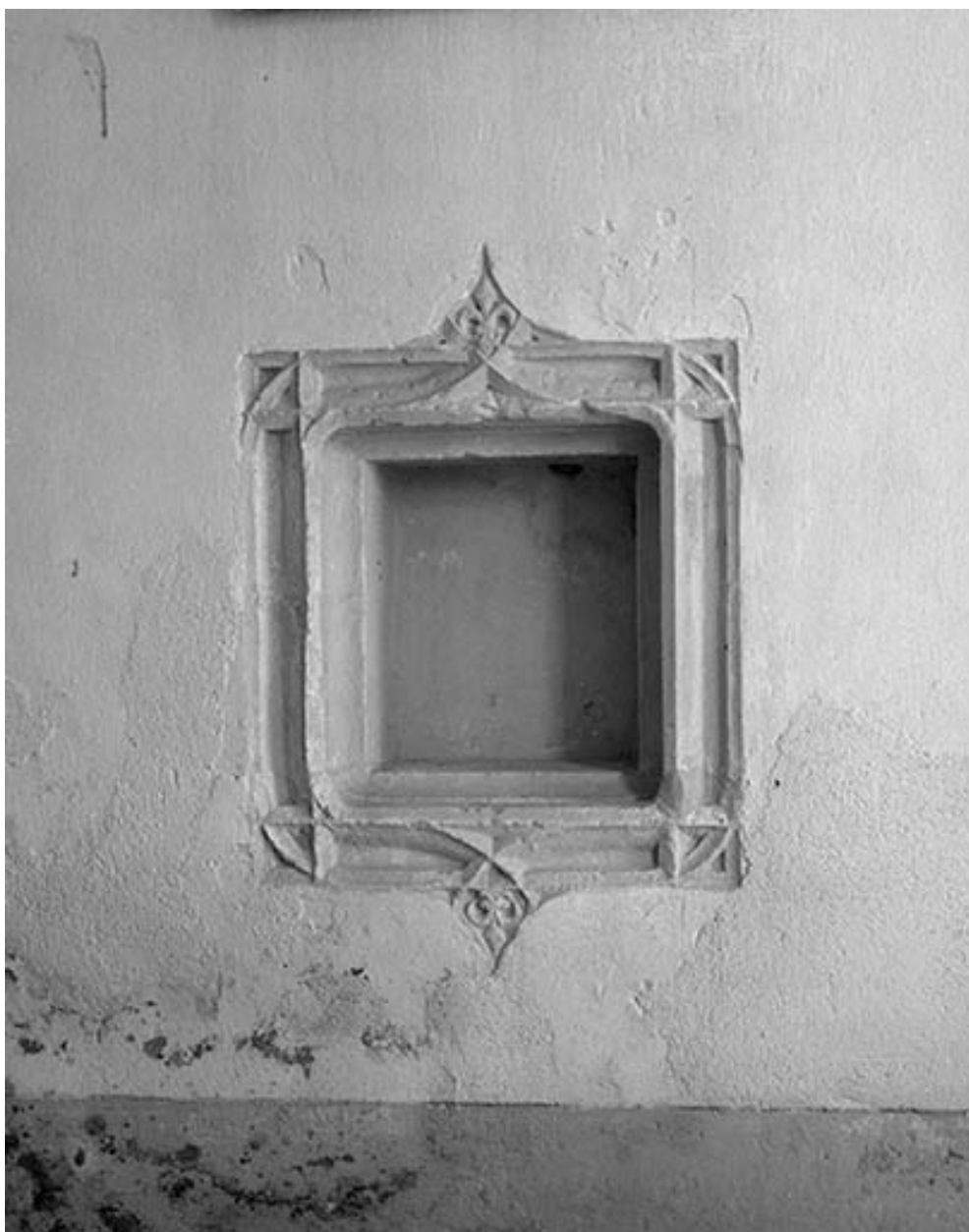
Extérieur : détail, niche.
