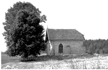
Façade latérale sud. Phot. Yves Sancey IVR43_19752500316X
