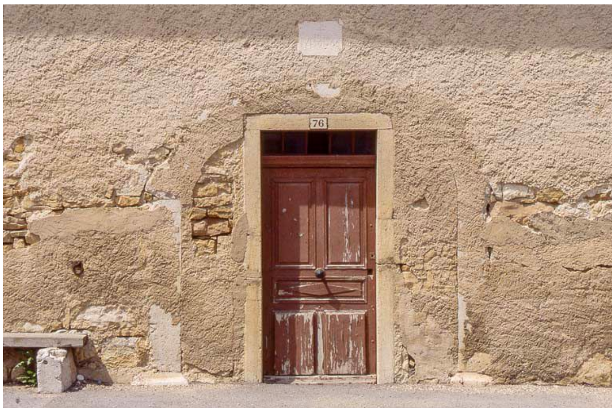
Porte sur la façade antérieure.
