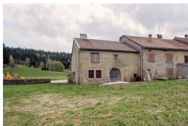
Vue éloignée de la façade postérieure. Phot. Yves Sancey IVR43_19993900254ZA
