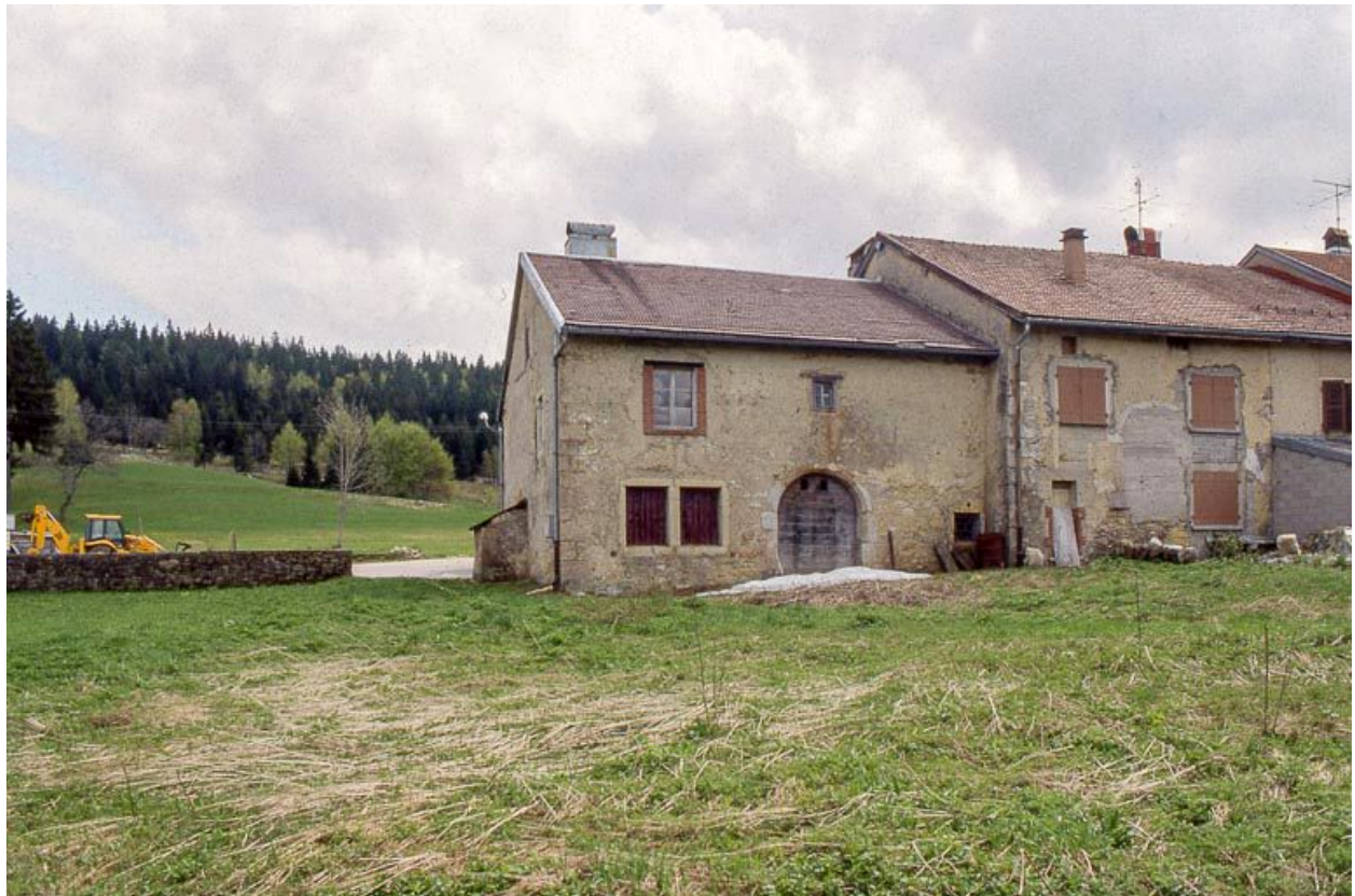
Vue éloignée de la façade postérieure.
