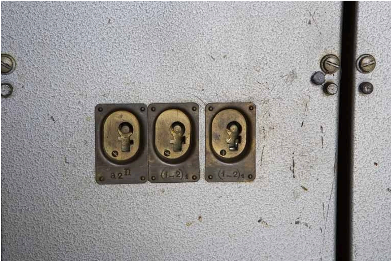
Bureau : serrures du transmetteur central.
