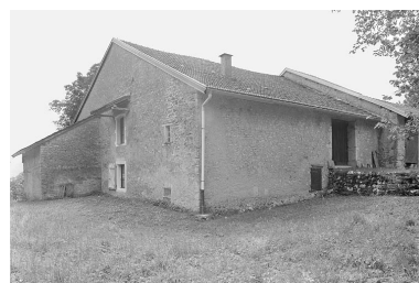
Face droite et façade postérieure. Phot. Jérôme Mongreville IVR43_19963901096X
