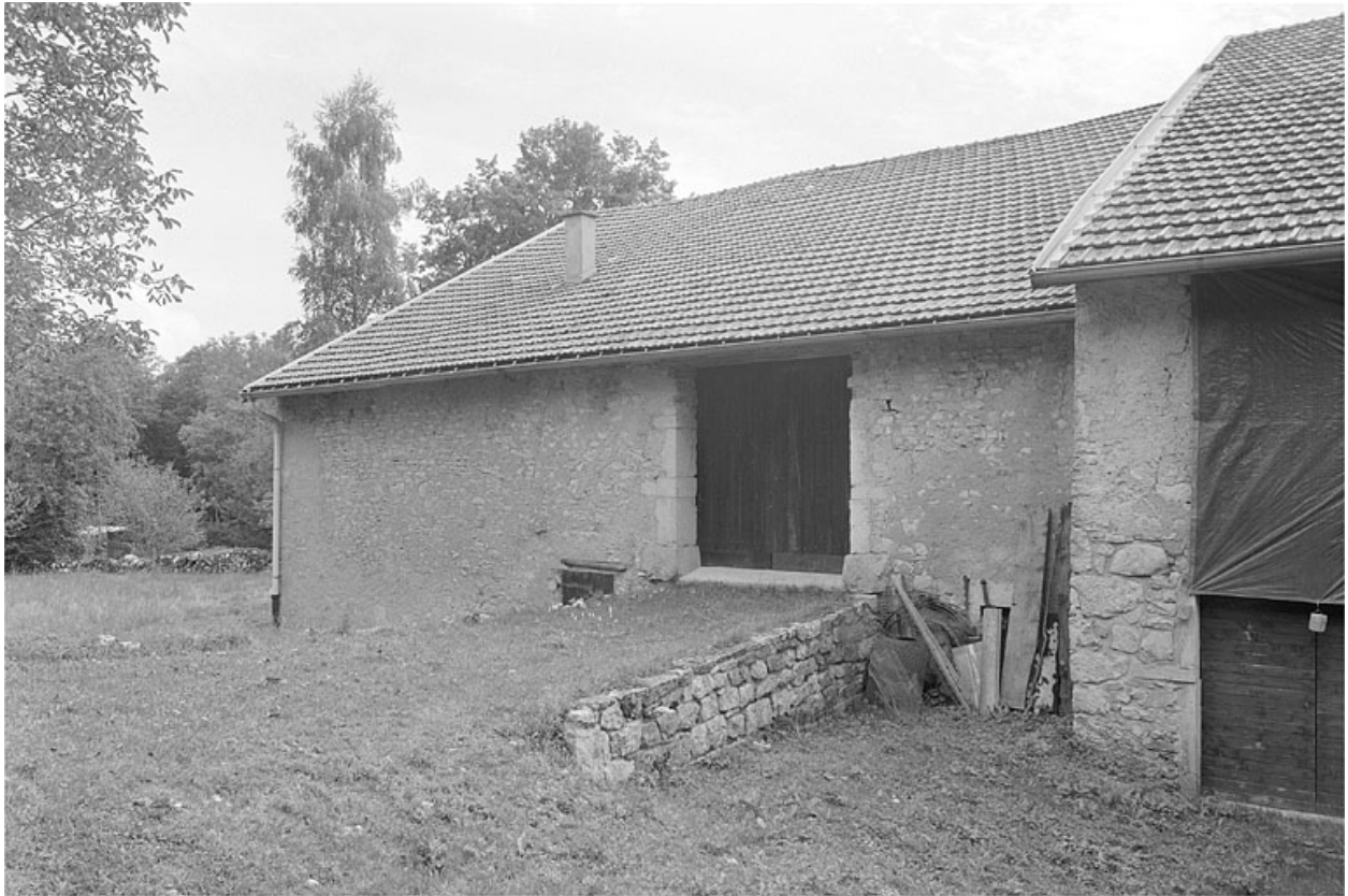
Façade postérieure, grange haute.
