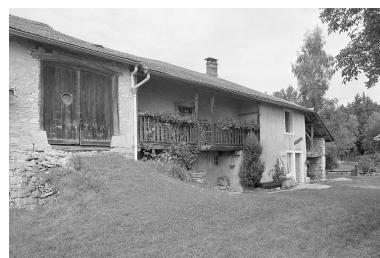
Façade antérieure, balcon en galerie. Phot. Jérôme Mongreville IVR43_19963901088X
