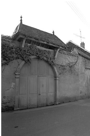
Portail d'entrée. Phot. Dominique Dominguez IVR43_19807000489X
