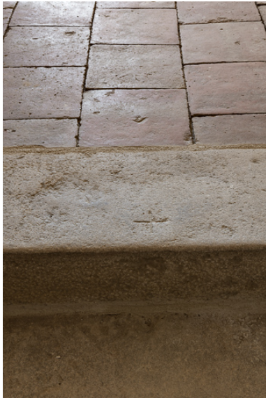
Détail de l'escalier : Marche et palier couvert de carreaux de carrelage en terre cuite Phot. Pierre-Marie Barbe-Richaud IVR26_20197100261NUC4A
