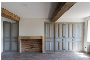
Une des chambres de l'étage avec sa cheminée (XVIII e siècle) et une série de placards, aménagée au début du XX e siècle Phot. Pierre-Marie Barbe-Richaud IVR26_20197100262NUC4A
