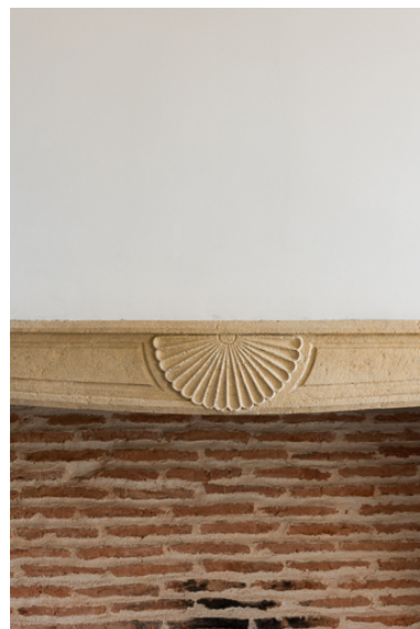
Linteau de la cheminée avec un décor de coquille Phot. Pierre-Marie Barbe-Richaud IVR26_20197100264NUC4A
