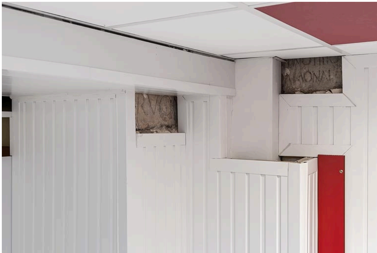
Deux plaques, à l'angle des deux ailes de l'établissement thermal.
