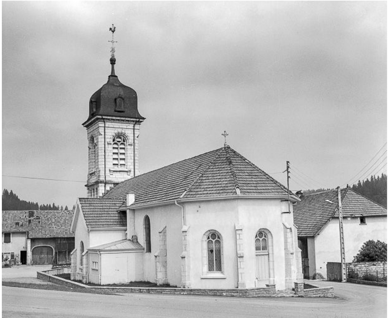
Façades postérieure et latérale droite.
