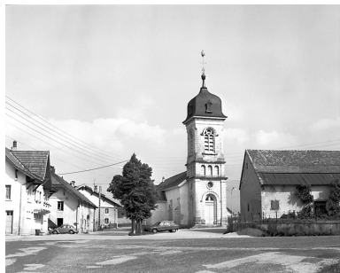
Vue d'ensemble sur la place du village. Phot. Yves Sancey IVR43_19792500759X
