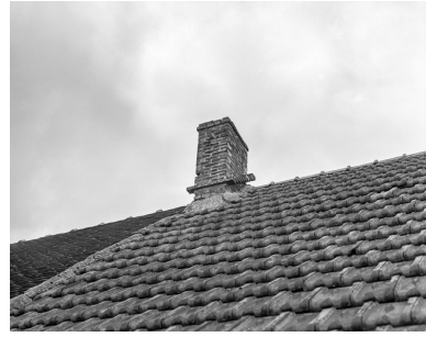
Vue du toit et de la cheminée. Phot. Dominique Dominguez IVR43_19773900104X
