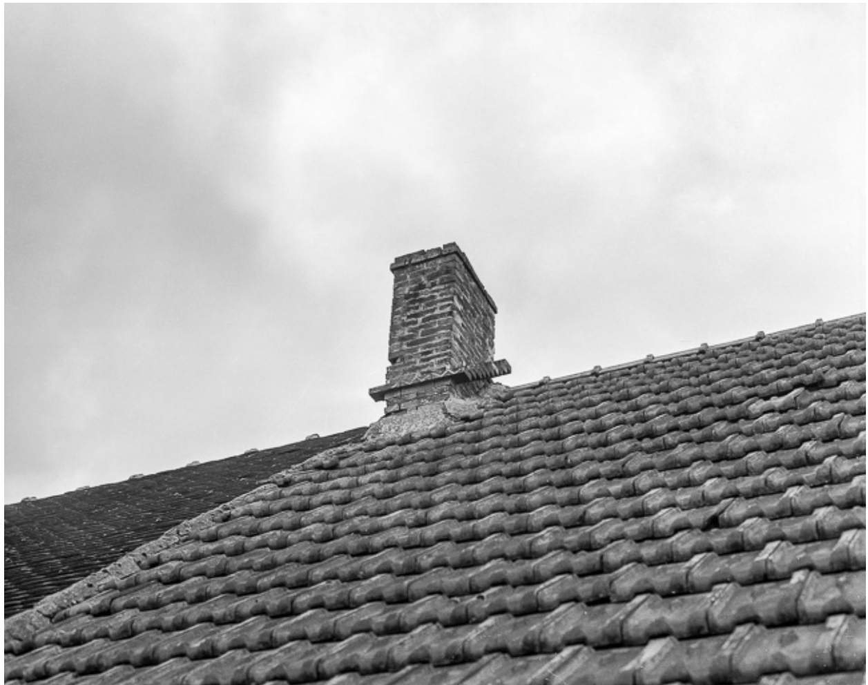
Vue du toit et de la cheminée.
