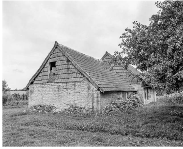
Façade postérieure et pignon droit. Phot. Dominique Dominguez IVR43_19773900103X
