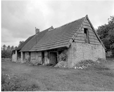
Façade antérieure. Phot. Dominique Dominguez IVR43_19773900102X
