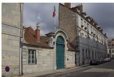
Façade, rue Charles Nodier : de trois quarts gauche. Phot. Yves Sancey IVR43_20112501797NUC2A
