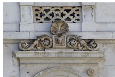
Façade d'angle, premier étage : détail du décor sur l'entablement d'une fenêtre. Phot. Yves Sancey IVR43_20112501802NUC2A
