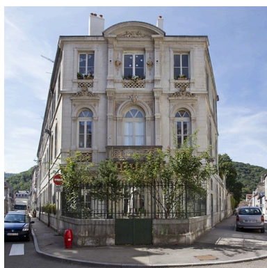
Façade d'angle : de face. Phot. Yves Sancey IVR43_20112501792NUC2A
