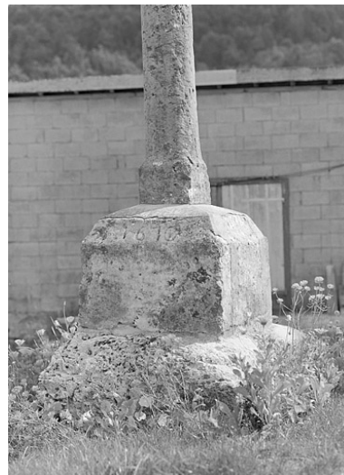
Date 1670 portée sur le socle. Phot. Jérôme Mongreville IVR43_19963901284X
