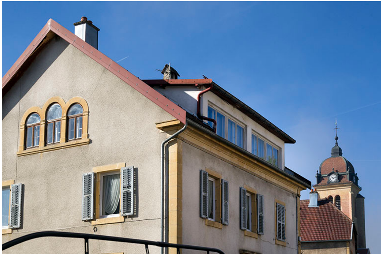
Etage et étage en surcroît (côté est).
