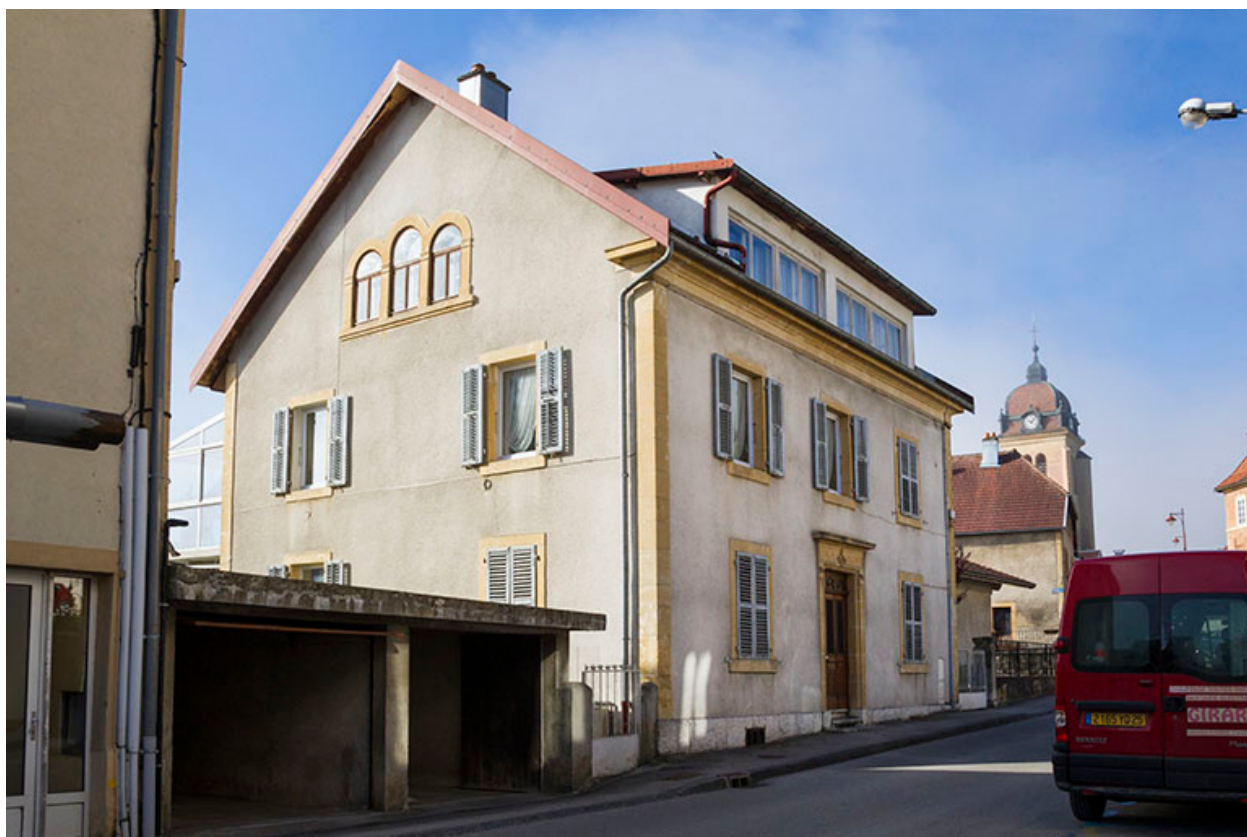
Façades antérieure et latérale gauche.
