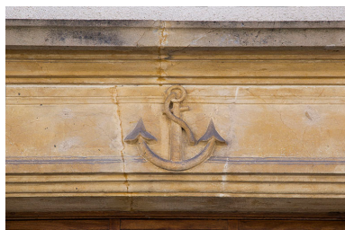
Ancre sculptée sur le linteau de l'entrée. Phot. Yves Sancey IVR43_20132502096NUC2A
