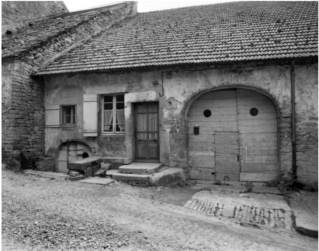
Façade antérieure, vue de face.
