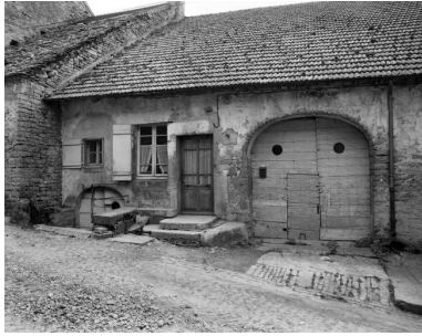
Façade antérieure, vue de face.
