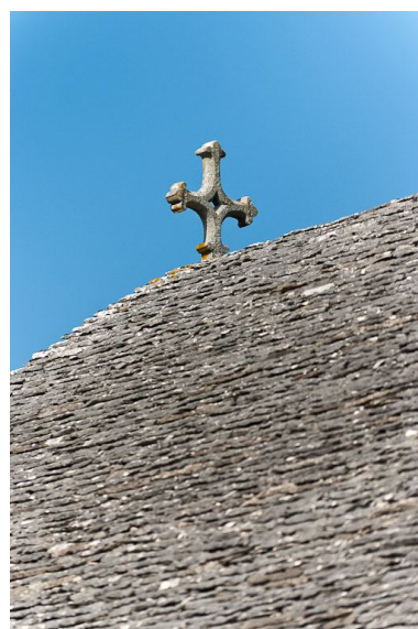
Détail de la toiture.
