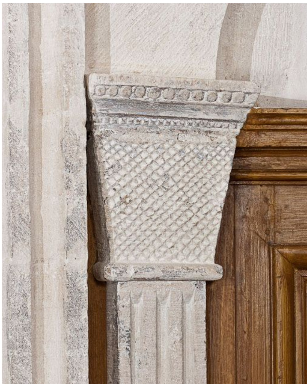
Premier chapiteau gauche de l'abside.
