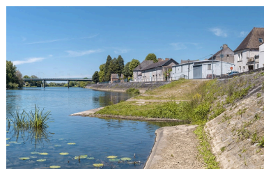
Les quais se poursuivent en aval du pont : rampe d'accès à la rivière. Phot. Thierry Kuntz IVR26_20172100266NUC4A
