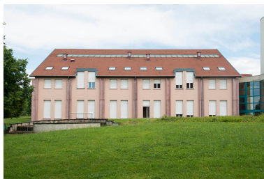
Façade antérieure sud de l'internat sud-ouest. Phot. Mary Ruffinoni IVR43_20137000470NUC4A
