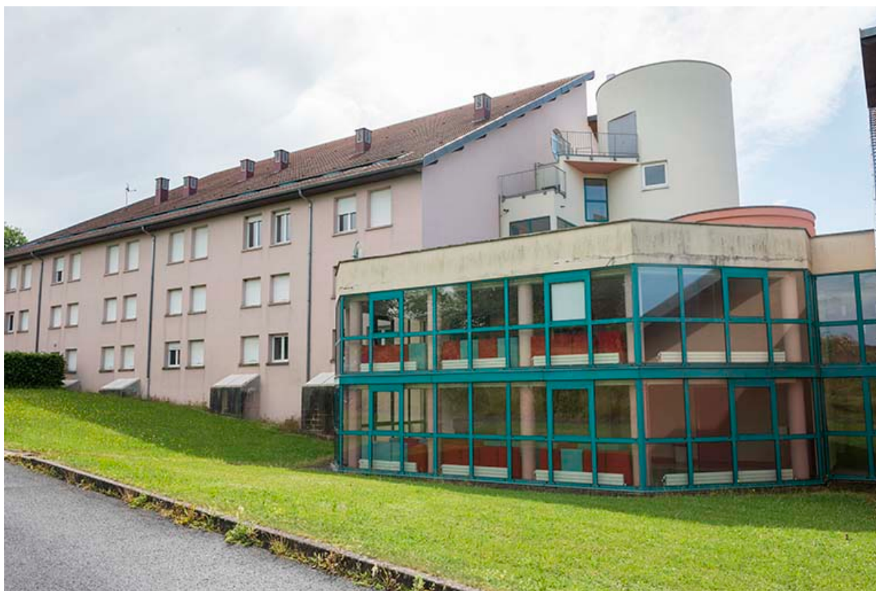
Façades postérieures nord de l'internat nord-est.
