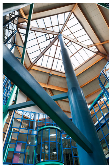
Intérieur et verrière de l'atrium. Phot. Jérôme Mongreville IVR43_20137000505NUC4A
