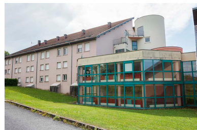
Façades postérieures nord de l'internat nord-est. Phot. Mary Ruffinoni IVR43_20137000475NUC4A
