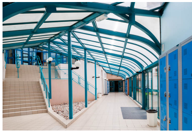
Circulation intérieure. Phot. Jérôme Mongreville IVR43_20137000520NUC4A
