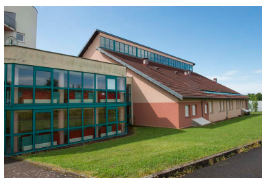
Façades postérieures nord de l'internat sud-ouest. Phot. Mary Ruffinoni IVR43_20137000476NUC4A
