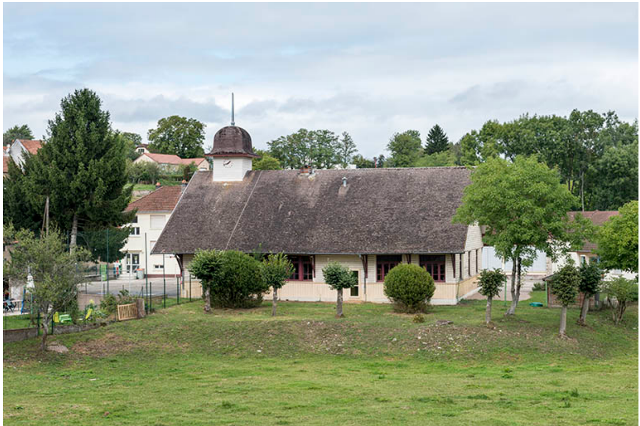
Vue depuis le pont.
