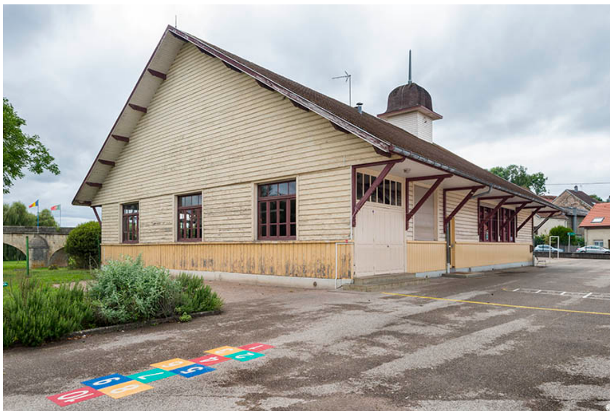
Vue depuis le fond de la cour.
