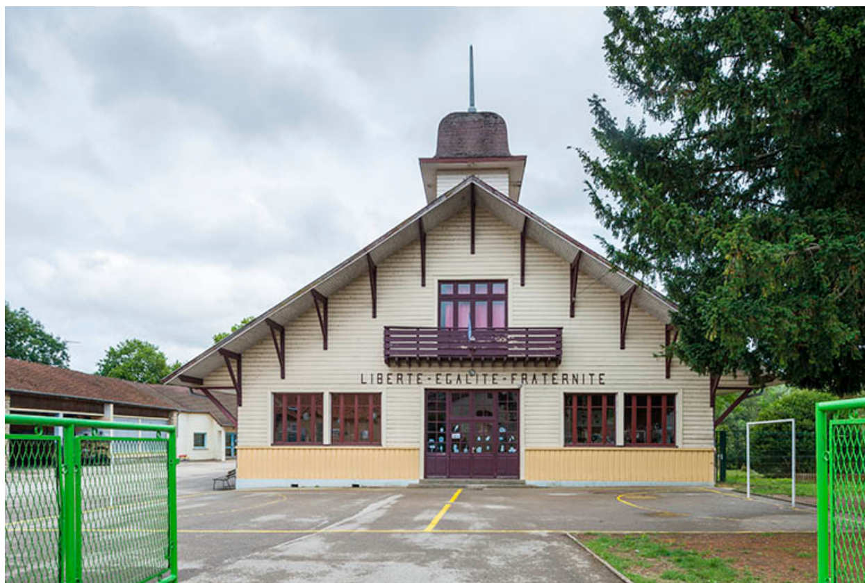
La façade principale.
