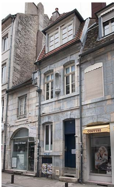
Façade sur rue de trois quarts droit. Phot. Jérôme Mongreville IVR43_20112500109NUC4A
