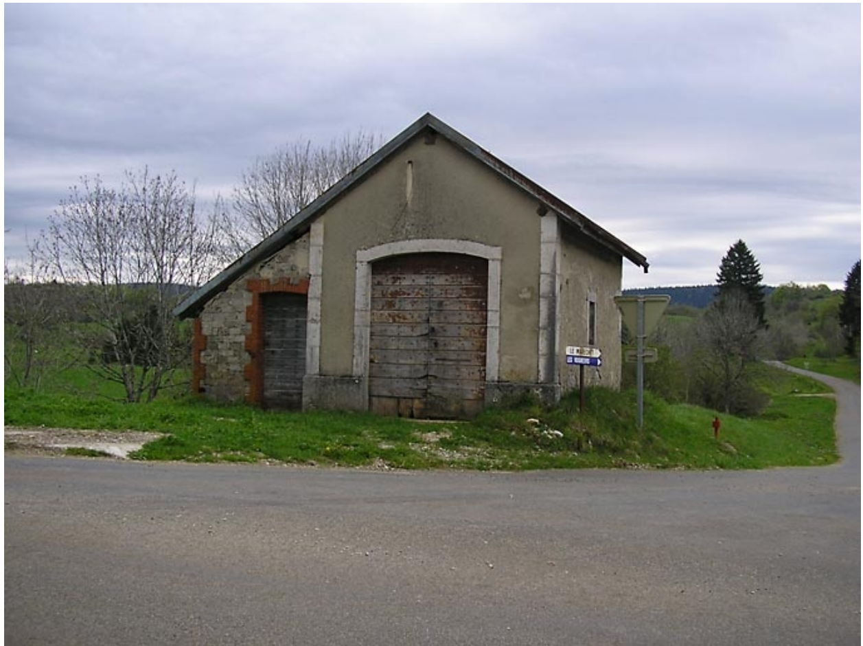
Façade antérieure et appentis.
