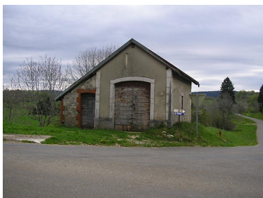
Façade antérieure et appentis. Phot. Marie-Pierre Reynet IVR43_20083900425NUC1A
