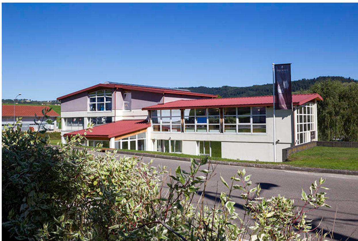
Façade latérale gauche, de trois quarts droite.
