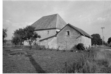
Façade postérieure. Phot. Gilbert Poinot IVR43_19762500827Z
