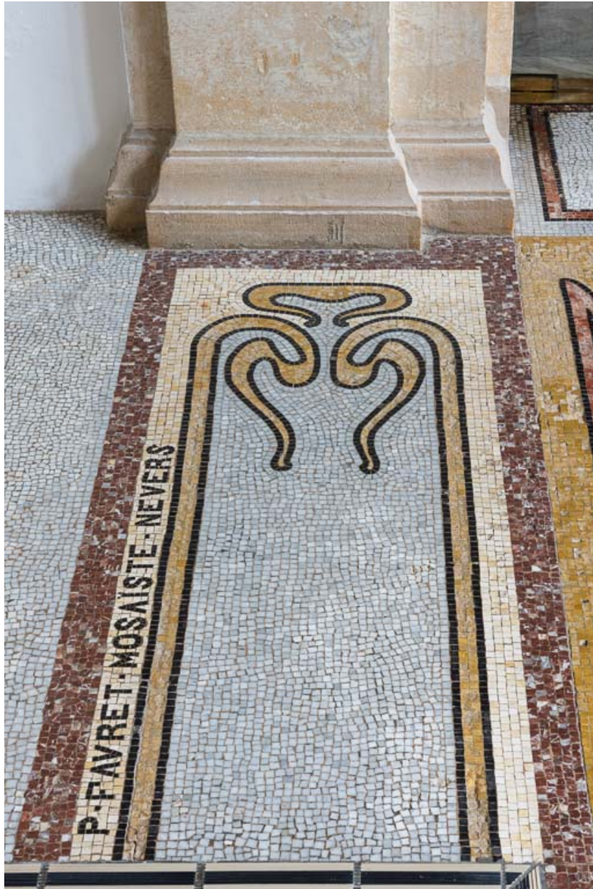
Signature au pied de la rampe sud du degré.
