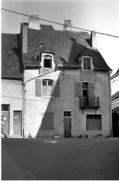
Façade sur rue. Phot. Bernard Lardière IVR43_19797000418Z
