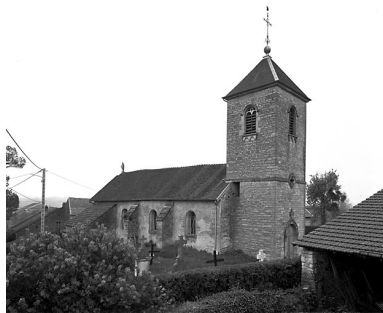
Clocher et façade latérale gauche.
