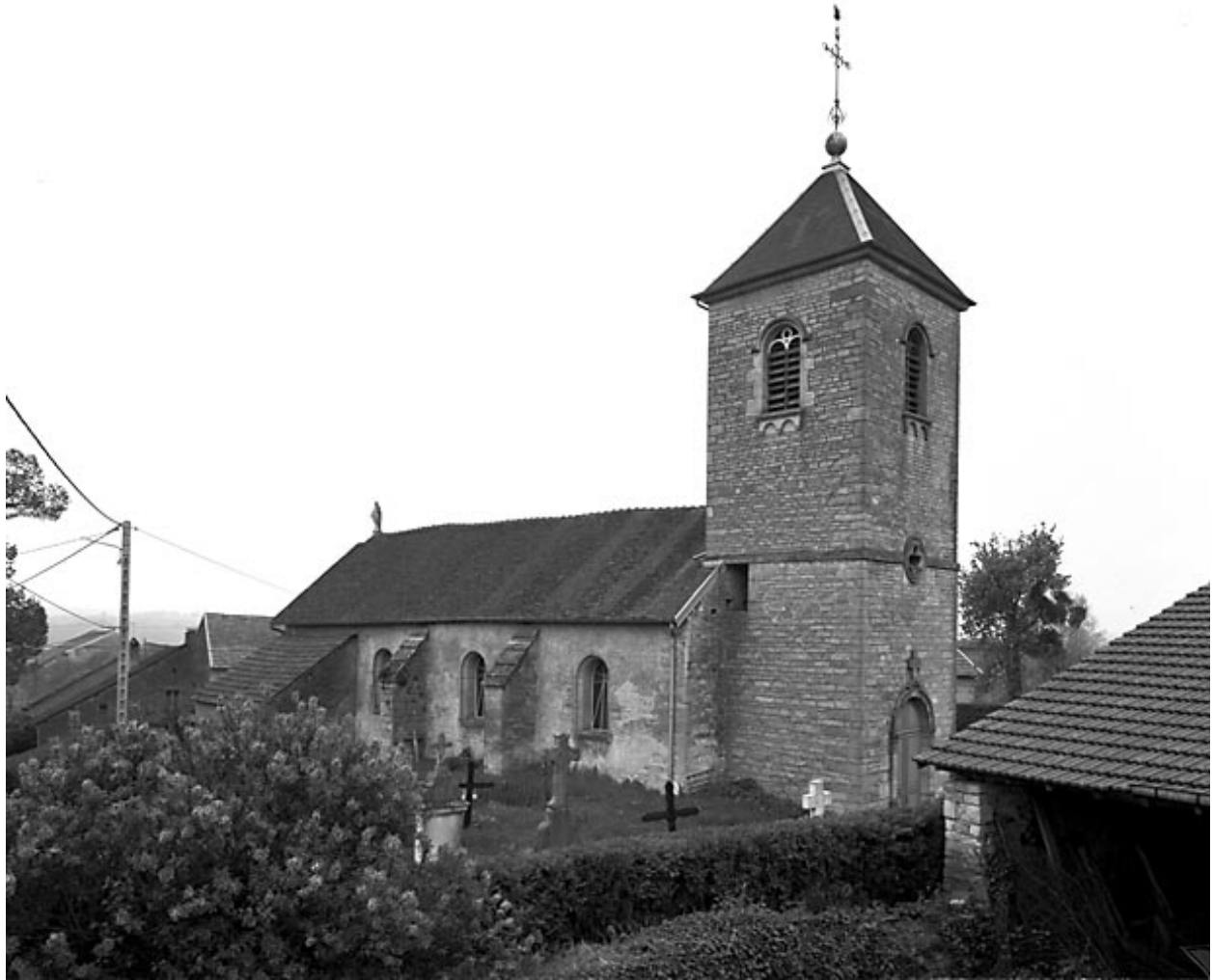
Clocher et façade latérale gauche.
