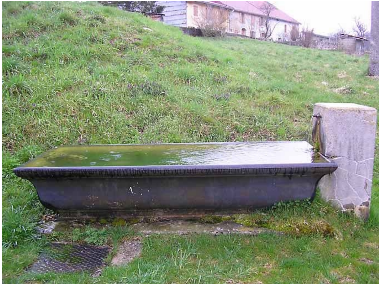
Vue sur l'ensemble hydraulique.
