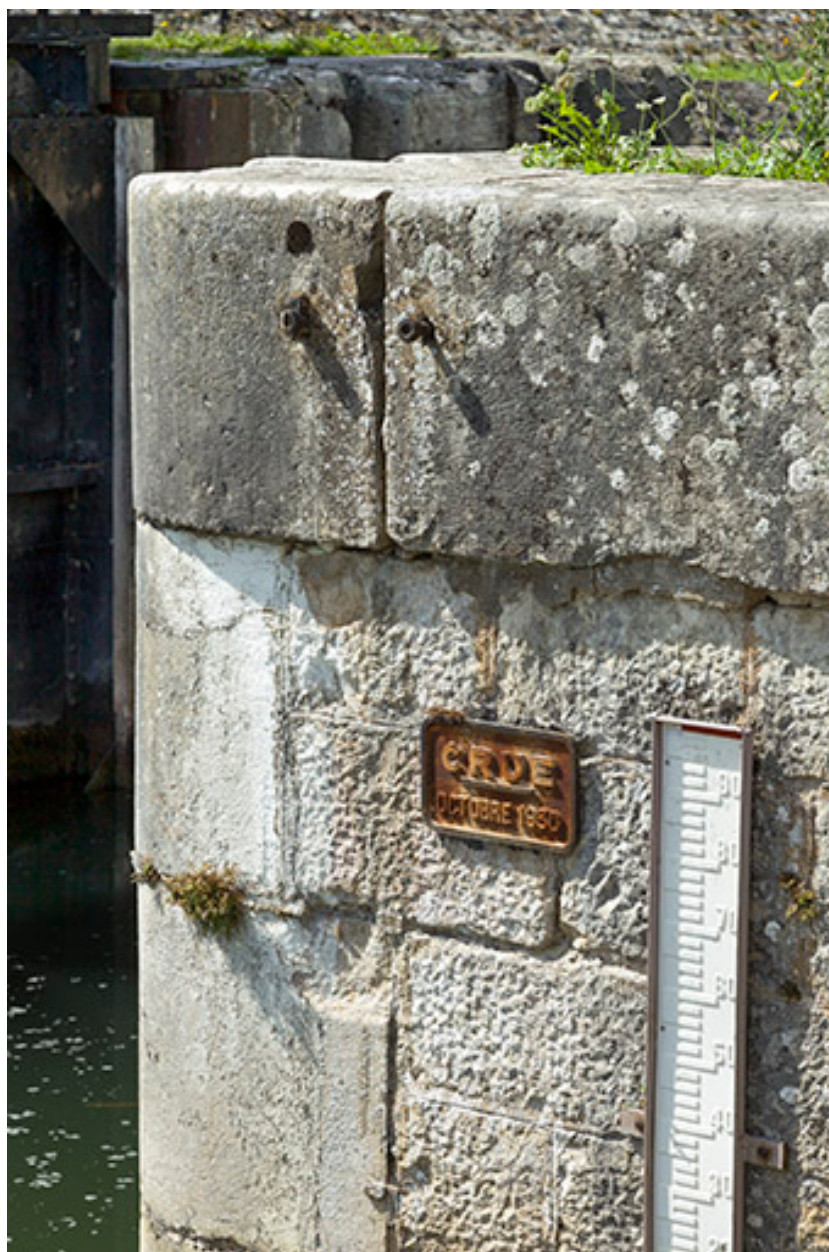
Repère de crue et échelle limnimétrique, porte de garde.
