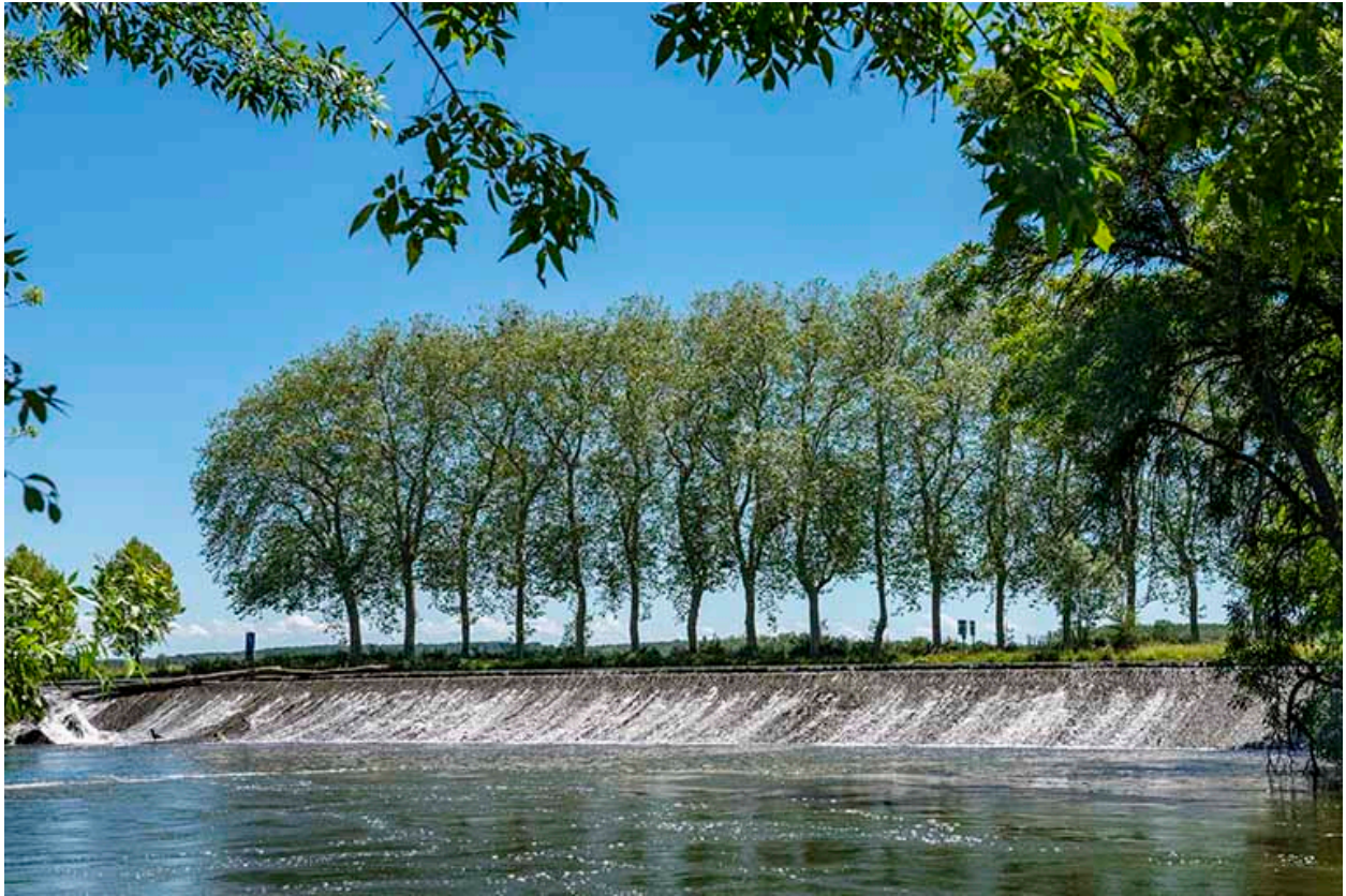
Déversoir en amont du barrage.
