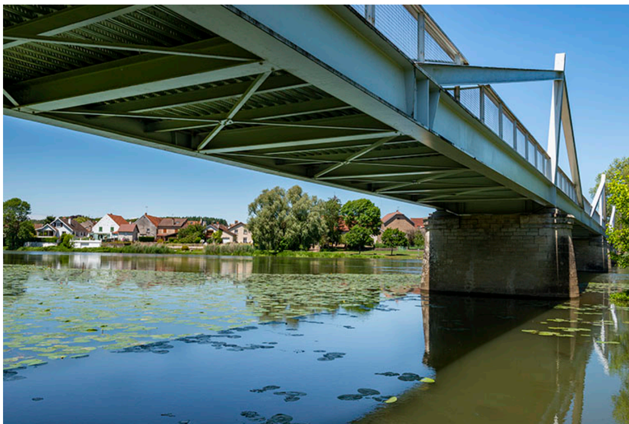
Tablier métallique du pont.
