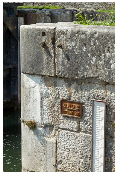
Repère de crue et échelle limnimétrique, porte de garde. Phot. Sonia Dourlot IVR43_20157001527NUC2A
