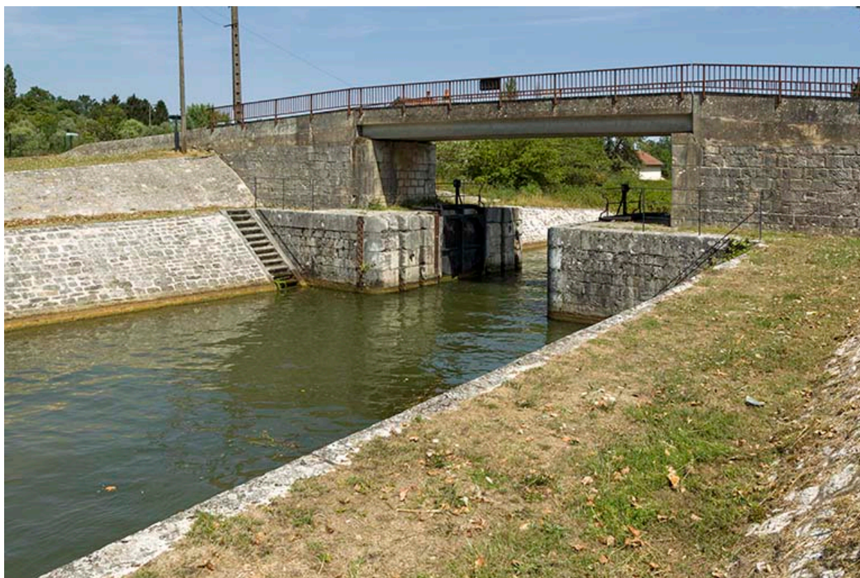
La porte de garde à l'entrée du canal.
