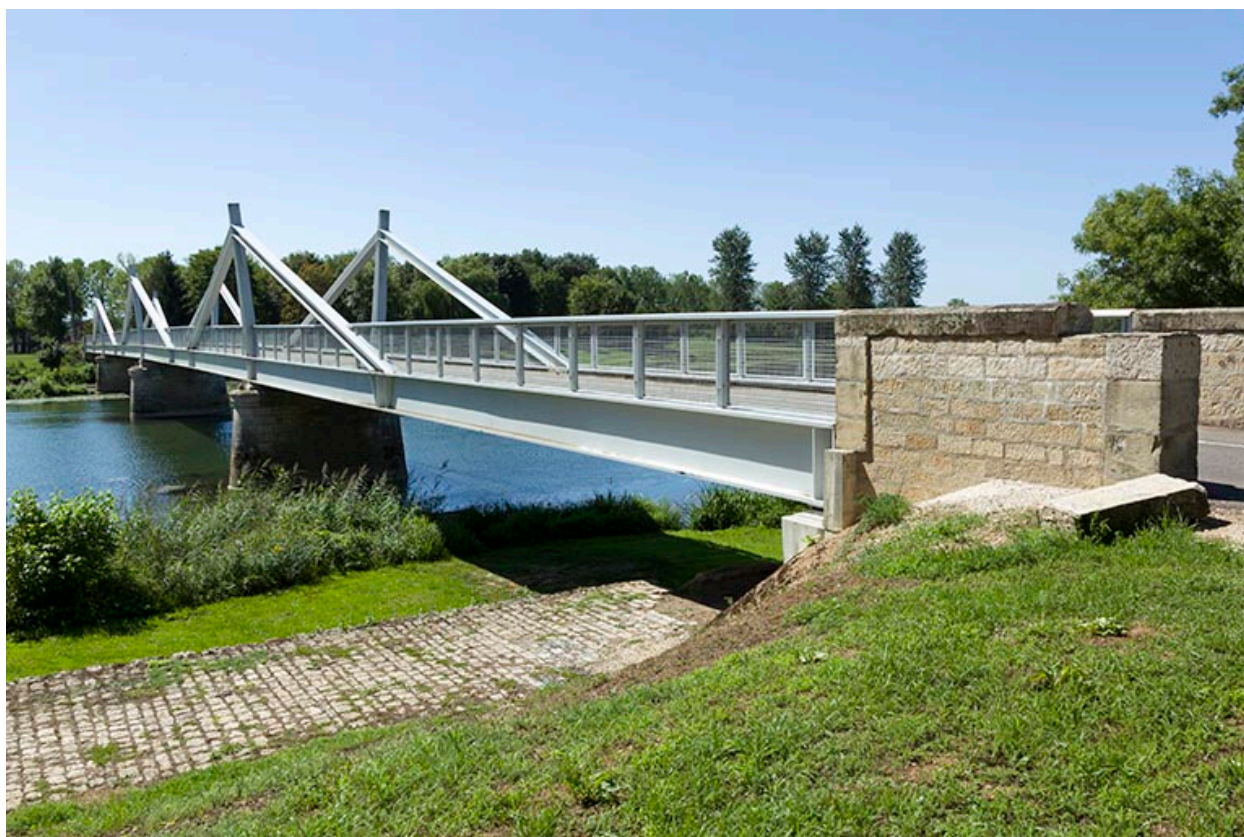
Le pont de Rigny et le chemin de halage en contrebas.
