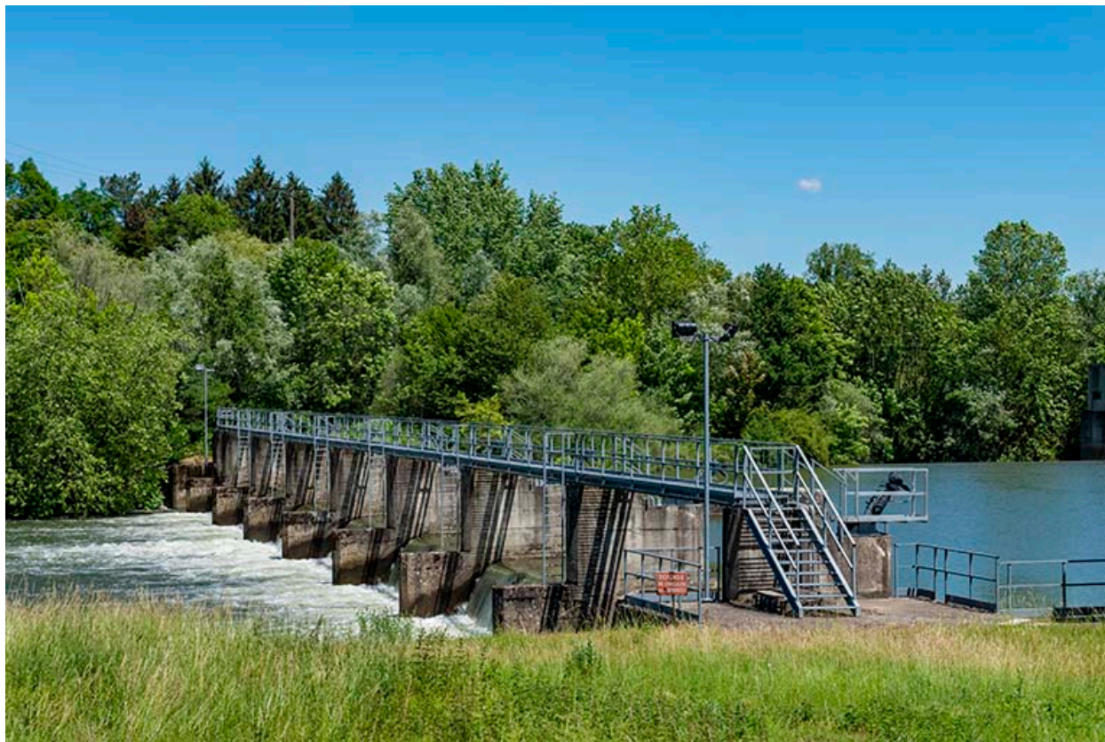
Le barrage mobile de Rigny.
