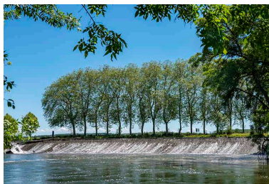
Déversoir en amont du barrage. Phot. Jérôme Mongreville IVR43_20197000348NUC4A
