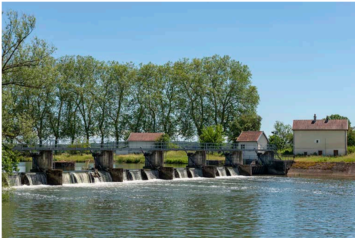
Vue depuis l'aval du barrage mobile.
