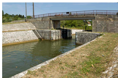
La porte de garde à l'entrée du canal. Phot. Sonia Dourlot IVR43_20157001524NUC2A
