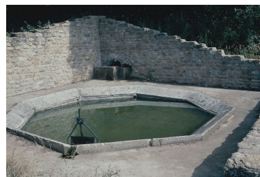
Vue extérieure. Phot. Jacques Druart IVR26_19937100300ZA
