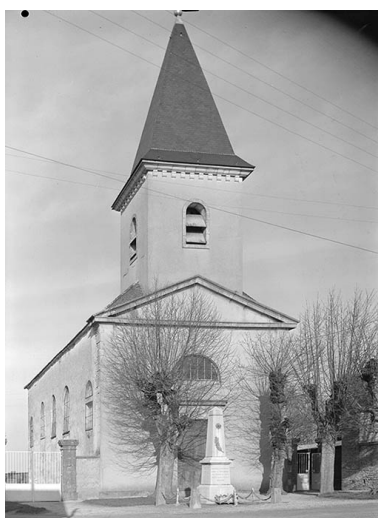
Façade occidentale à fronton triangulaire, avec clocher. Phot. Jean-Luc Duthu IVR26_19748901112V
