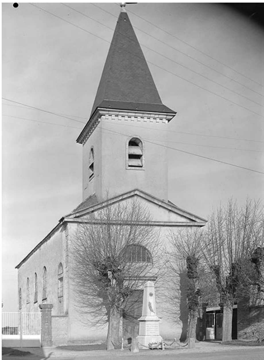
Façade occidentale à fronton triangulaire, avec clocher.
