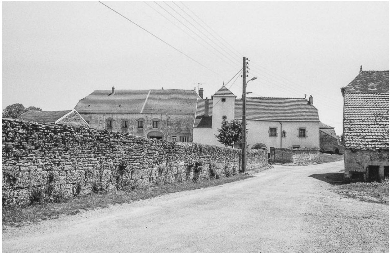
Vue éloignée du bâtiment depuis la rue.
