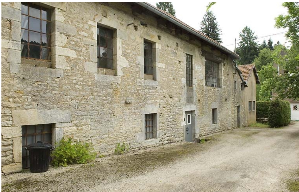
Façade ouest de l'atelier de fabrication.
