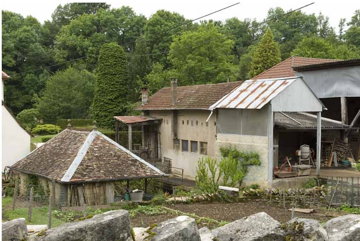
Les bâtiments industriels depuis le sud-est.
