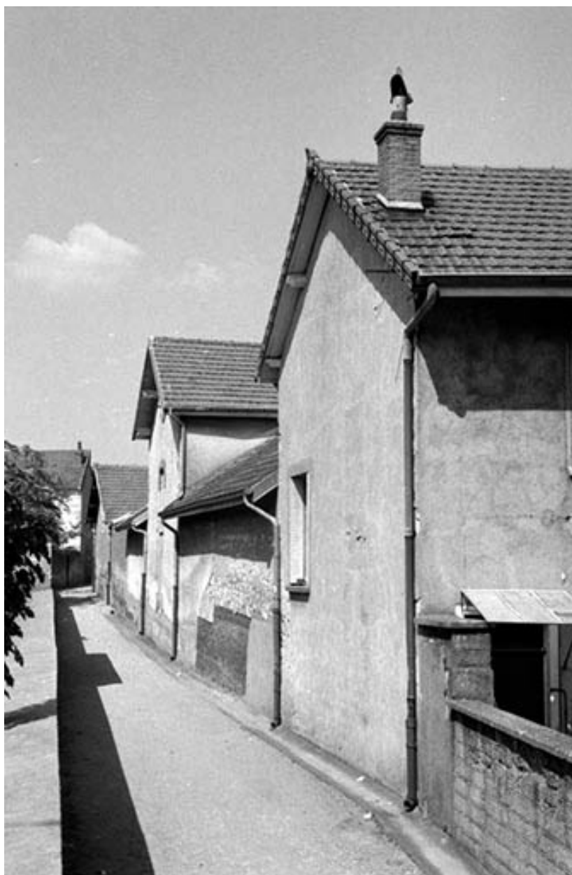
Façade postérieure des magasins industriels.
