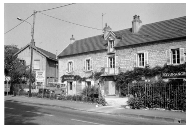
Bureau-logement patronal et magasin industriel (I). Phot. Laurent Poupard IVR43_19893900180Z
