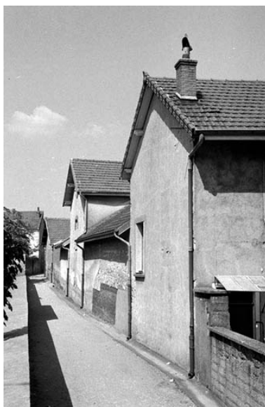
Façade postérieure des magasins industriels. Phot. Laurent Poupard IVR43_19893900182Z
