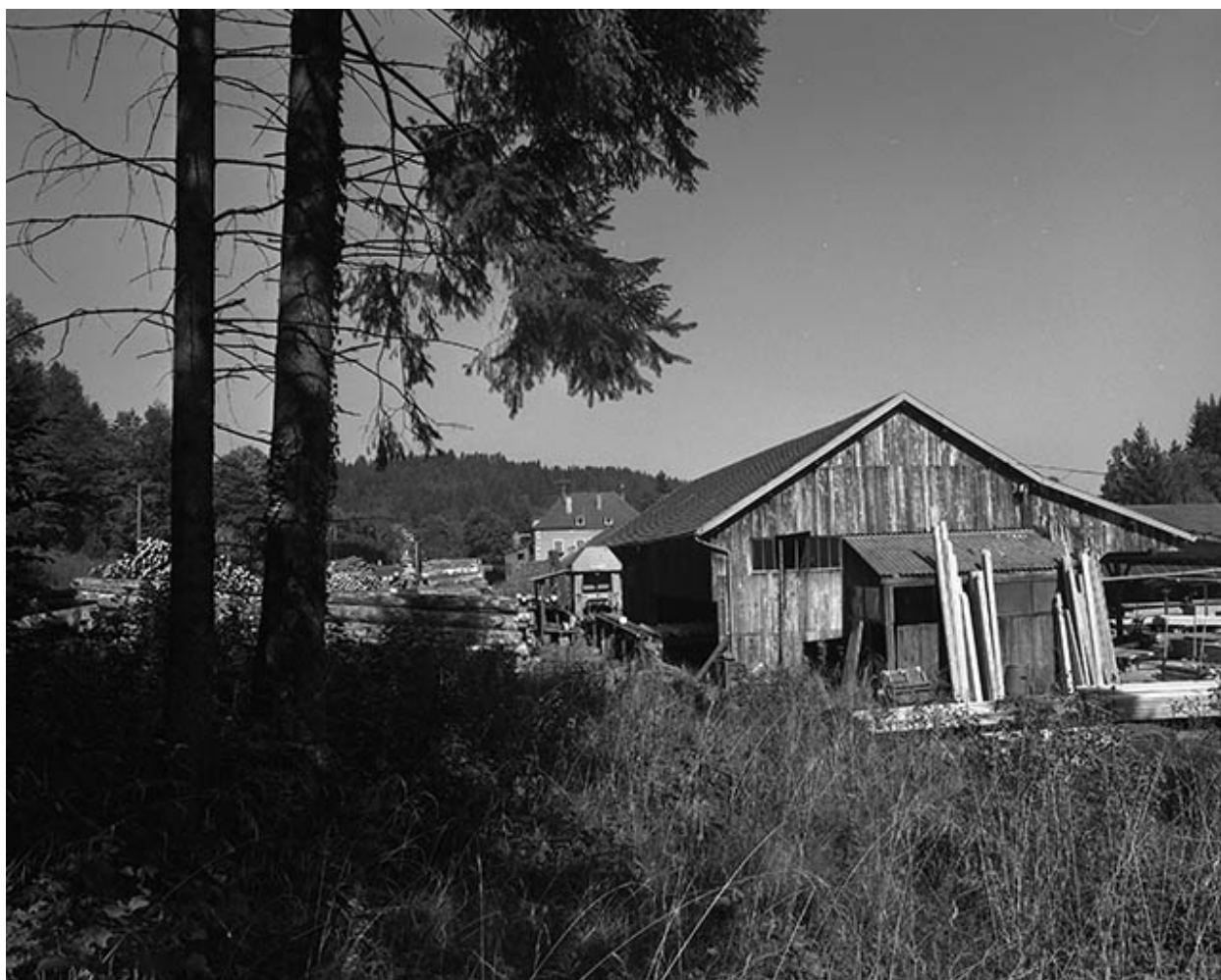
Atelier de fabrication (sciage) depuis le sud.
