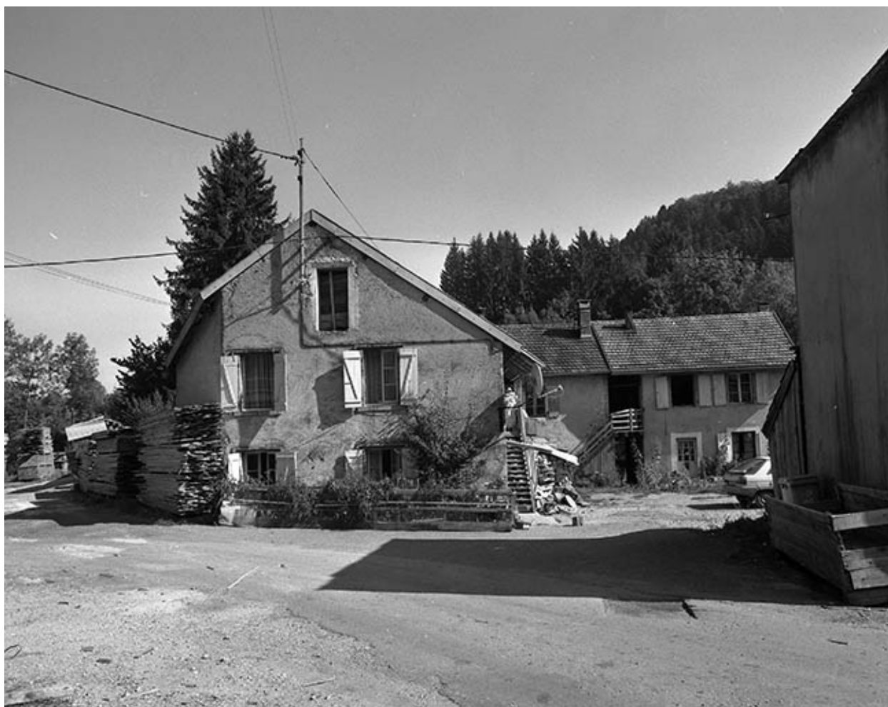
Logements d'ouvriers depuis l'ouest.
