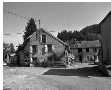
Logements d'ouvriers depuis l'ouest.
