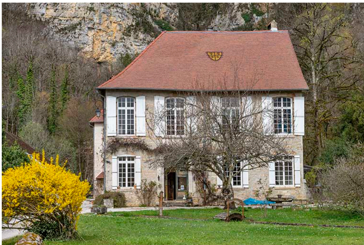
Façade sud du logis abbatial (cadrage horizontal).
