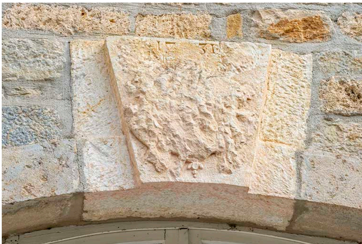
Clef d'arcade bûchée. Façade ouest du logis.
