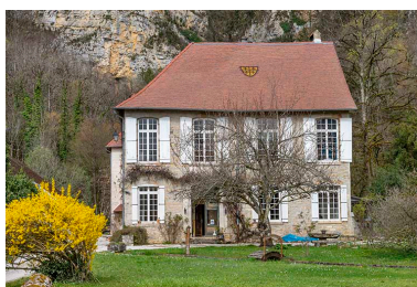
Façade sud du logis abbatial (cadrage horizontal). Phot. Jérôme Mongreville IVR43_20233900164NUC4A
