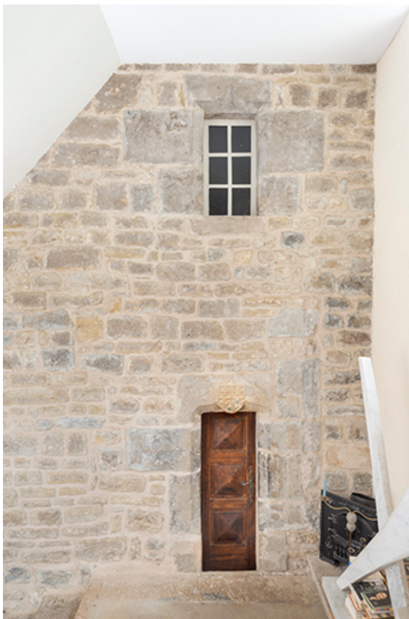
Intérieur du logis. Partie de mur médiéval.
