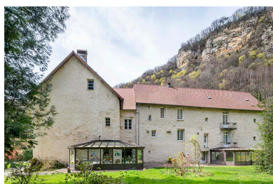
Façade nord des bâtiments. Phot. Jérôme Mongreville IVR43_20233900168NUC4A
