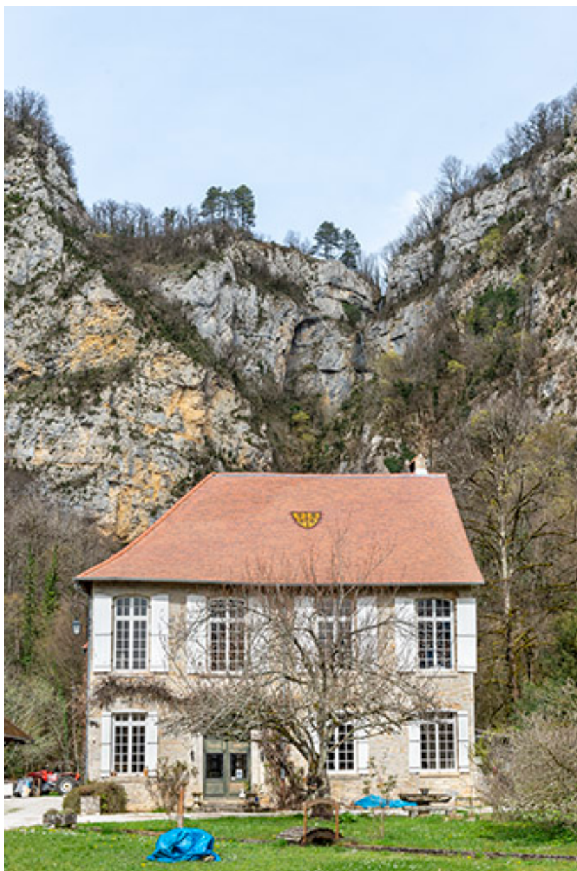
Façade sud du logis abbatial (cadrage vertical).
