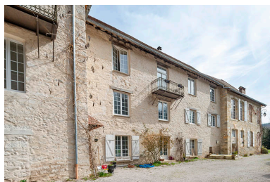
Façades ouest du logis. Phot. Jérôme Mongreville IVR43_20233900170NUC4A
