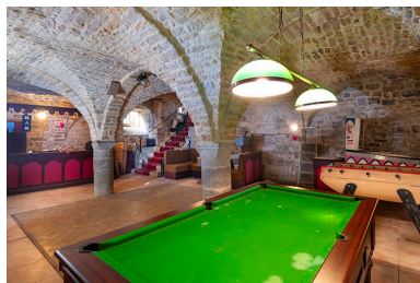
Cave voûtée d'arêtes, vue depuis le sud-ouest. Phot. Jérôme Mongreville IVR43_20233900185NUC4A
