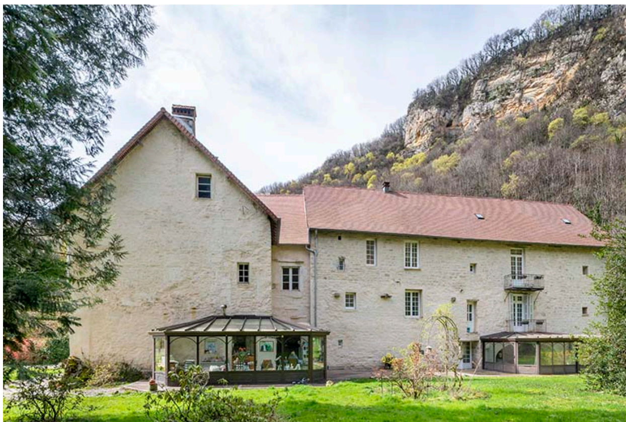
Façade nord des bâtiments.
