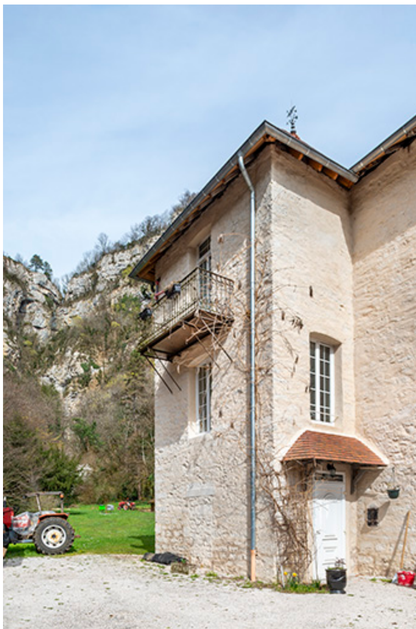
Elévation ouest de l'extrémité du logis.
