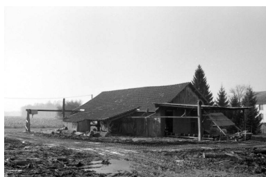
Atelier de fabrication, vu du nord-ouest. Phot. Laurent Poupard IVR43_19893900008Z
