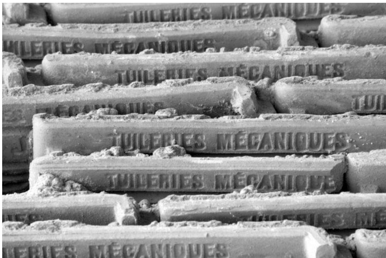
Détail de l'appareil de tuiles en gros-oeuvre.
