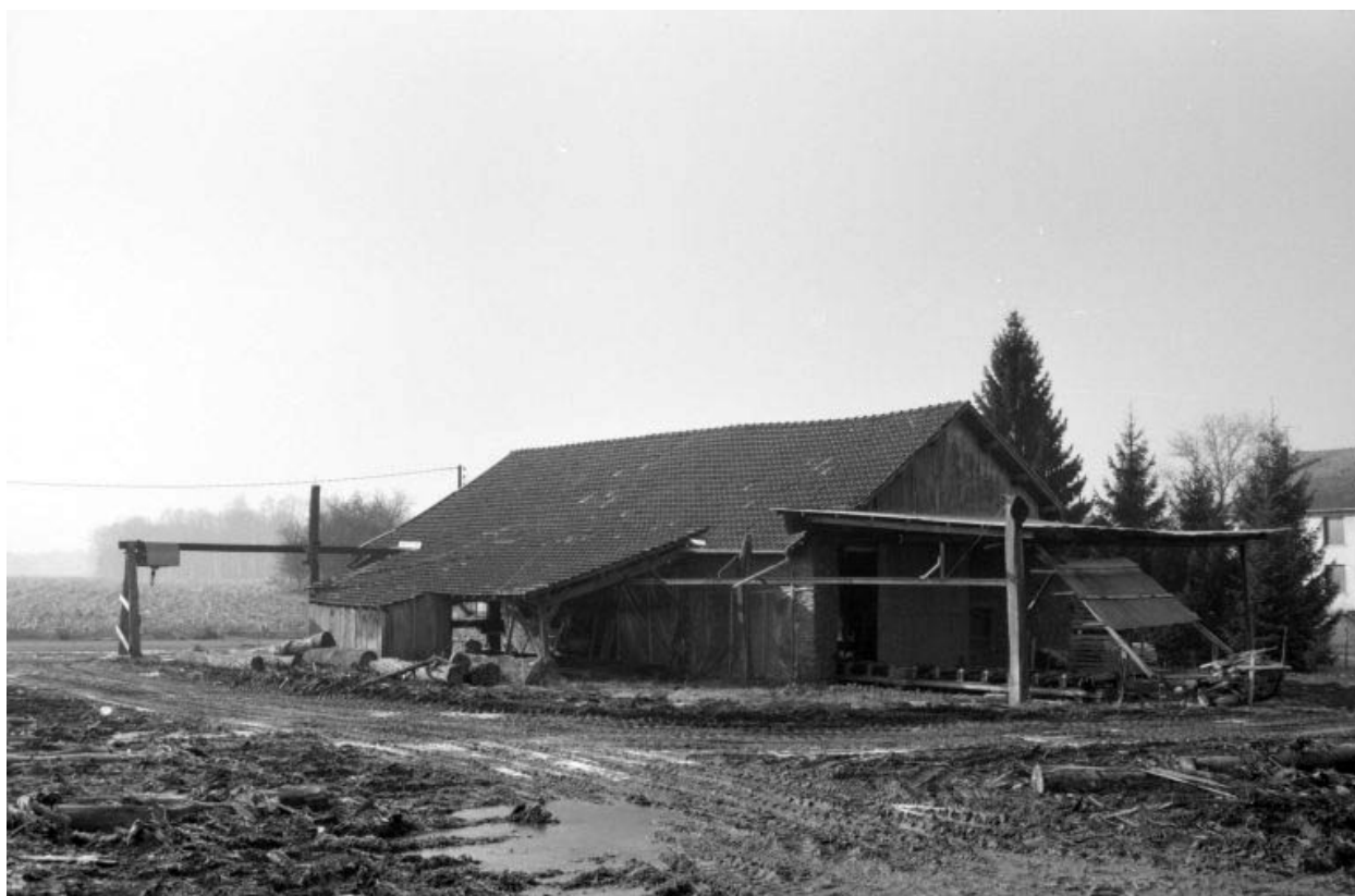
Atelier de fabrication, vu du nord-ouest.
