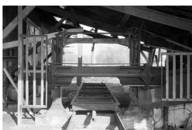
Scie "manchette" : châssis horizontal à lame unique. Le châssis est actionné par la bielle oblique à droite. Phot. Laurent Poupard IVR43_19893900010Z
