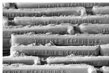
Détail de l'appareil de tuiles en gros-oeuvre. Phot. Laurent Poupard IVR43_19893900012Z
