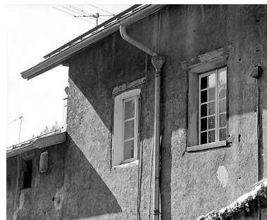
Façade postérieure : fenêtre du deuxième étage, à linteau en bois délardé en arc segmentaire. Phot. Yves Sancey IVR43_20033900062X
