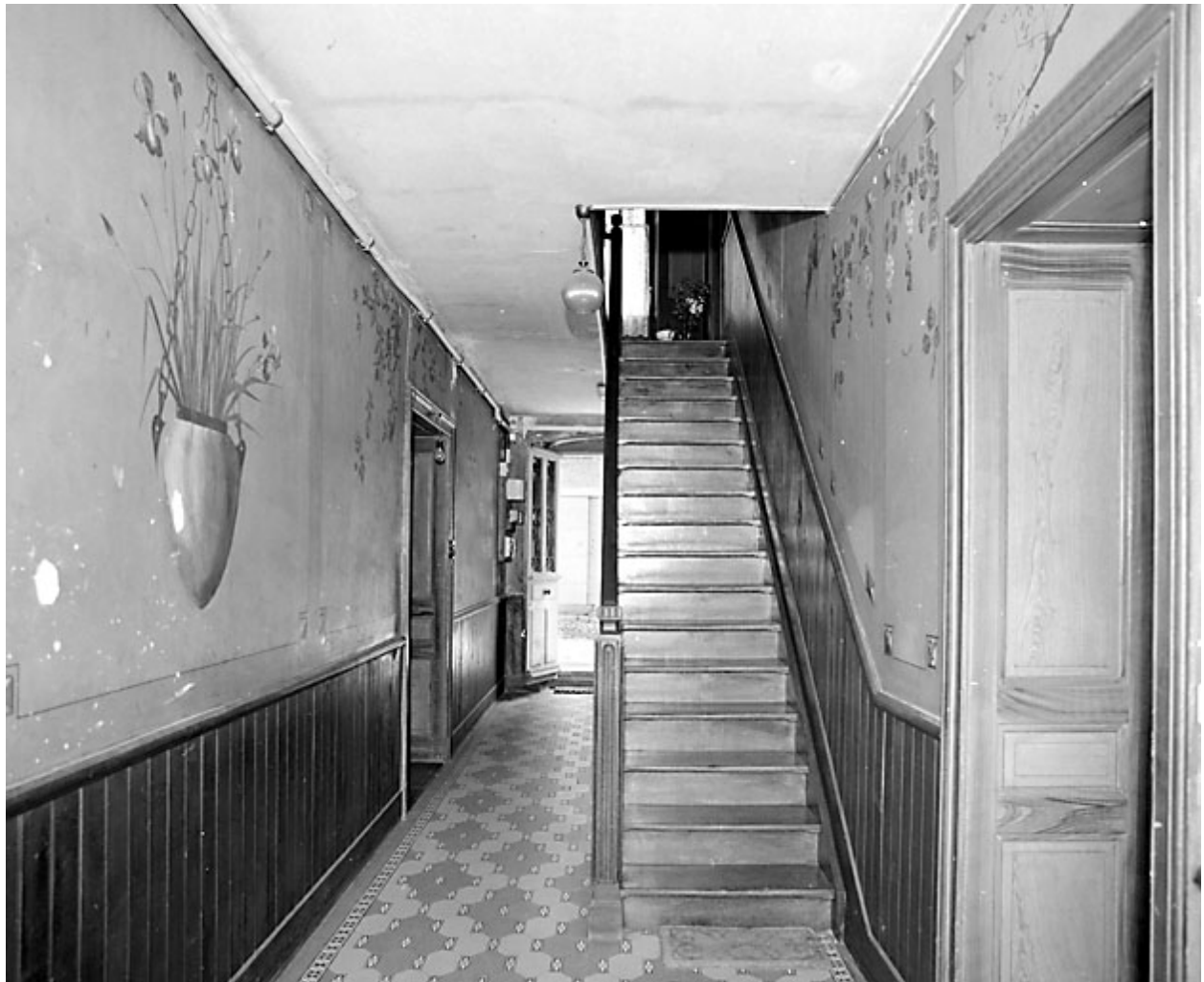
Couloir et escalier droit.
