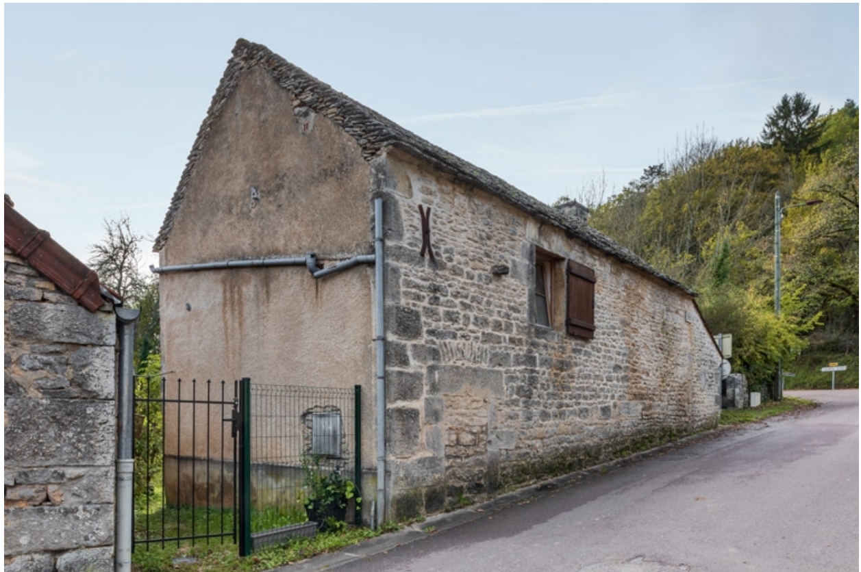
Détail du mur pignon est.
