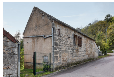
Détail du mur pignon est. Phot. Pierre-Marie Barbe-Richaud IVR26_20222100996NUC4A
