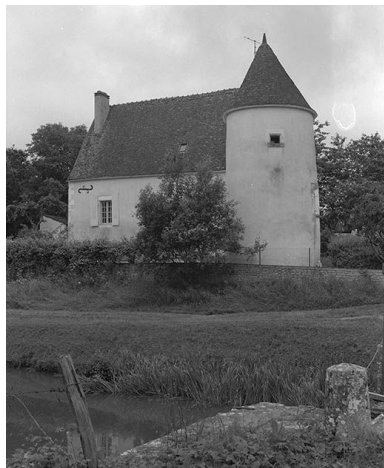
Vue d'ensemble. Phot. Jean-Luc Duthu IVR26_19935800131X
