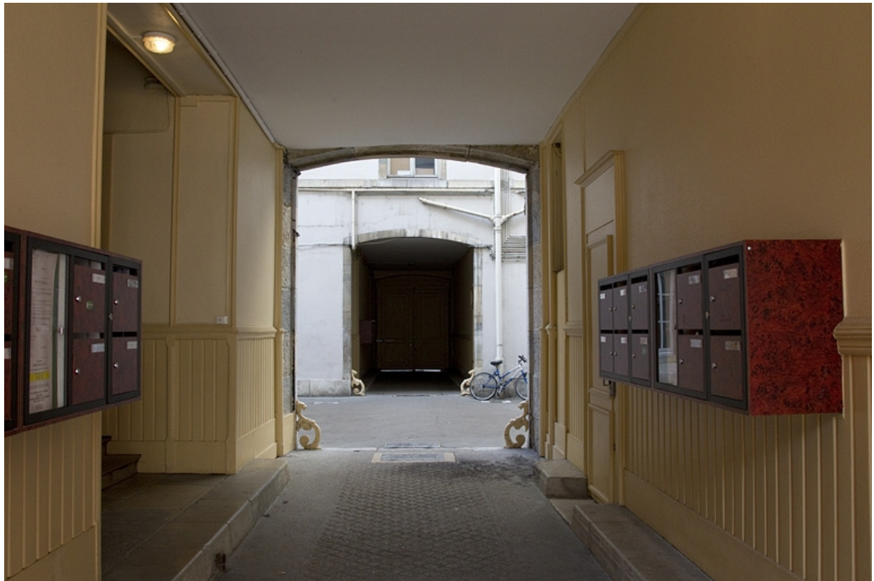
Vue d'ensemble des passages cochers en enfilade.
