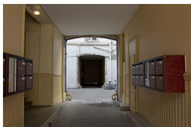
Vue d'ensemble des passages cochers en enfilade.
