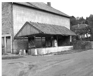
Fontaine-lavoir située rue de Tarcenay, à l'angle de la rue de Malbrans Phot. Yves Sancey IVR43_19802501201X
