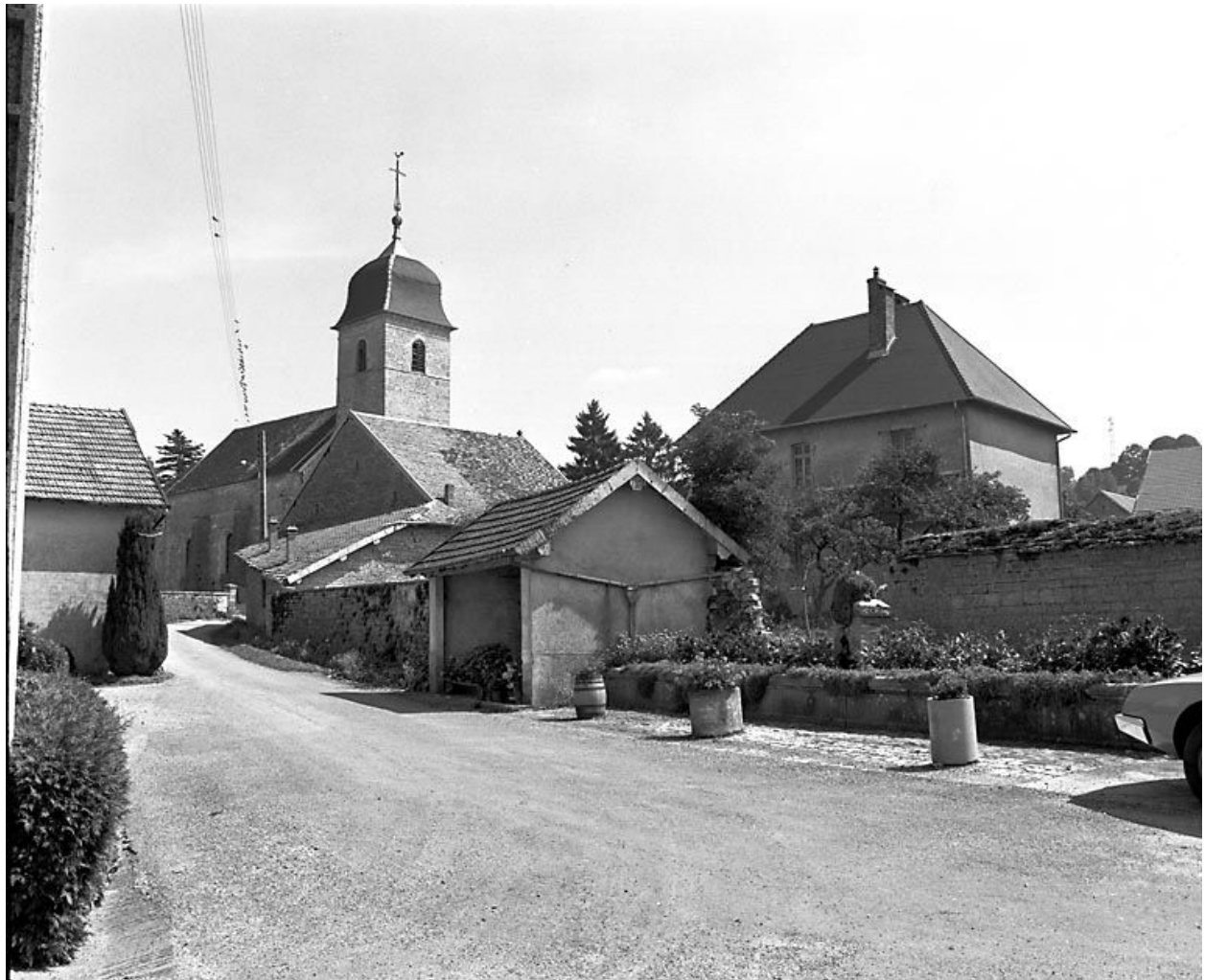
Fontaine-lavoir située rue de l'Eglise.
