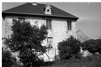
Presbytère. Phot. Gilbert Poinot IVR43_19762500908Z
