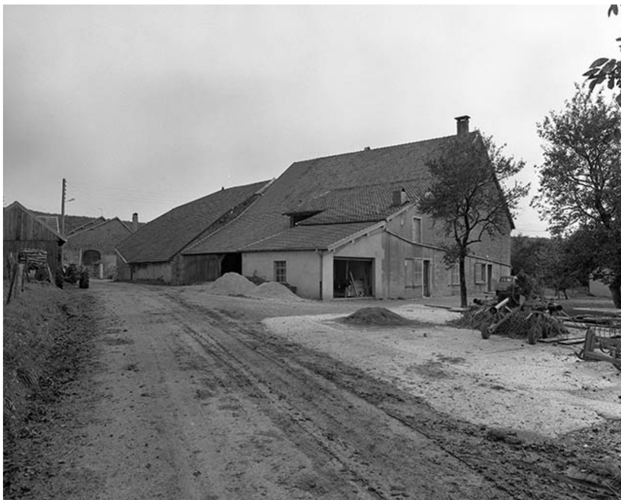
Ferme située 5 rue de Naglans.
