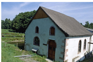
Salle des machines. Phot. Yves Sancey IVR43_19999000123ZA
