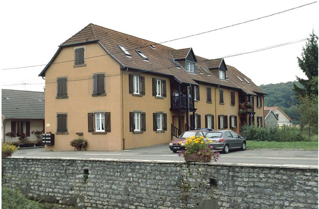
Logement ouvrier collectif.
