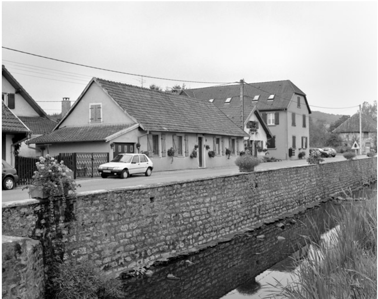
Vue de trois quarts des logements ouvriers.
