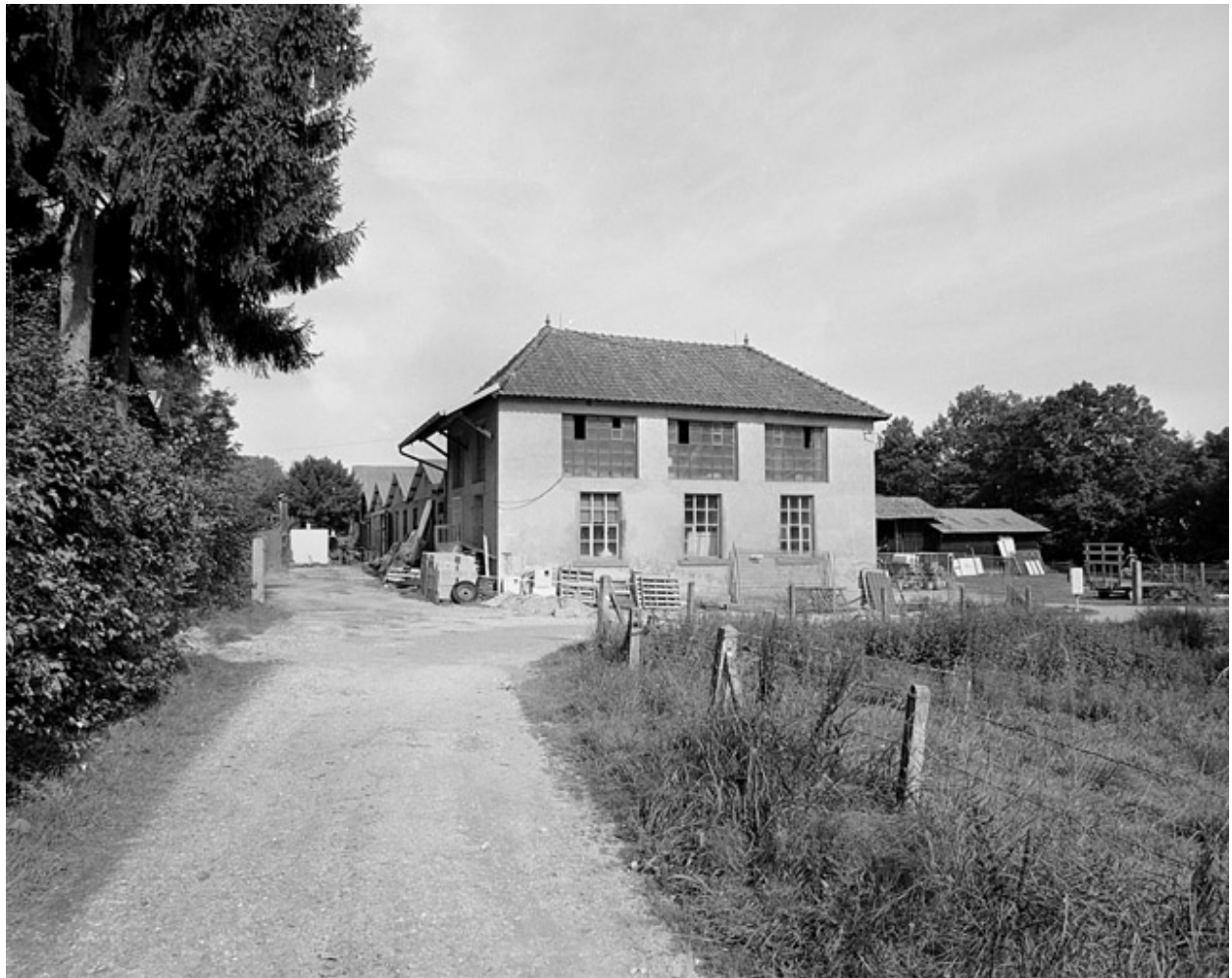
Atelier de réparation et bureau.
