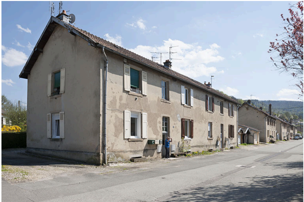
Façades ouest des habitations (côté impair).
