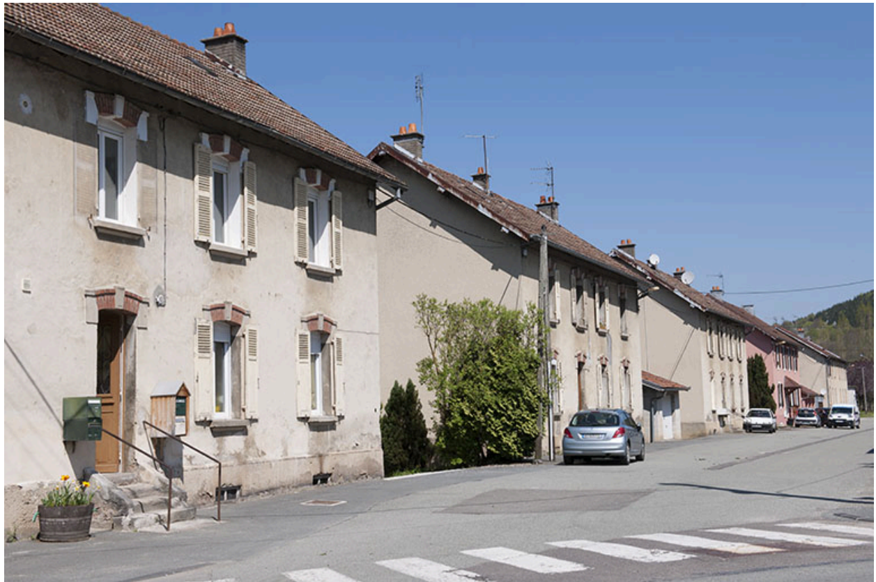
Alignement de façades rue du 4e R.T.T.
