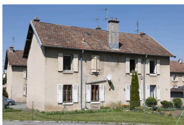
Façade postérieure d'une habitation. Phot. Jérôme Mongreville IVR43_20132500240NUC4A
