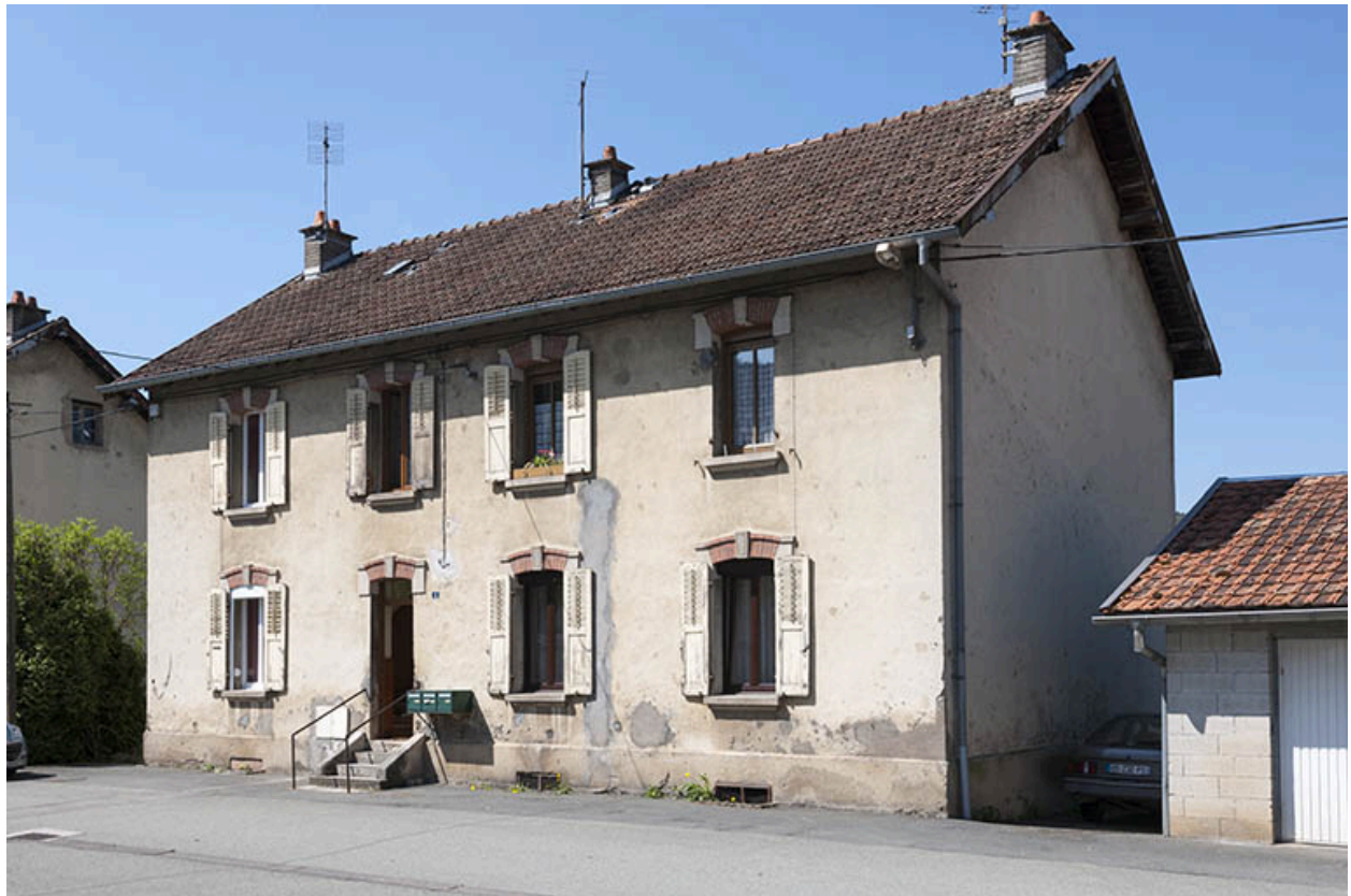
Habitation vue de trois quarts droite.
