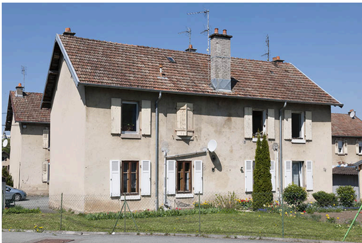
Façade postérieure d'une habitation.
