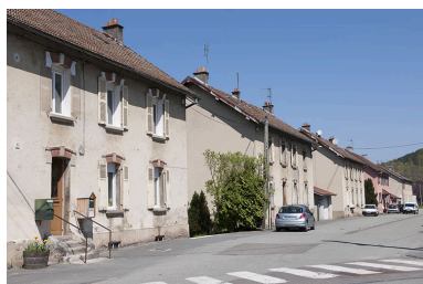
Alignement de façades rue du 4e R.T.T. Phot. Jérôme Mongreville IVR43_20132500241NUC4A
