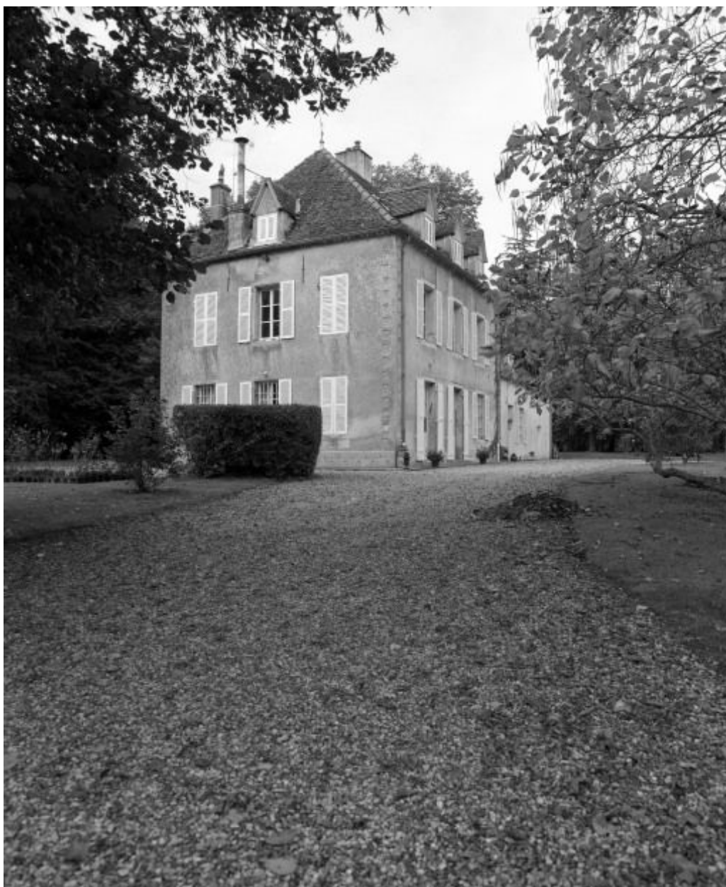
Logis, élévation gauche.
