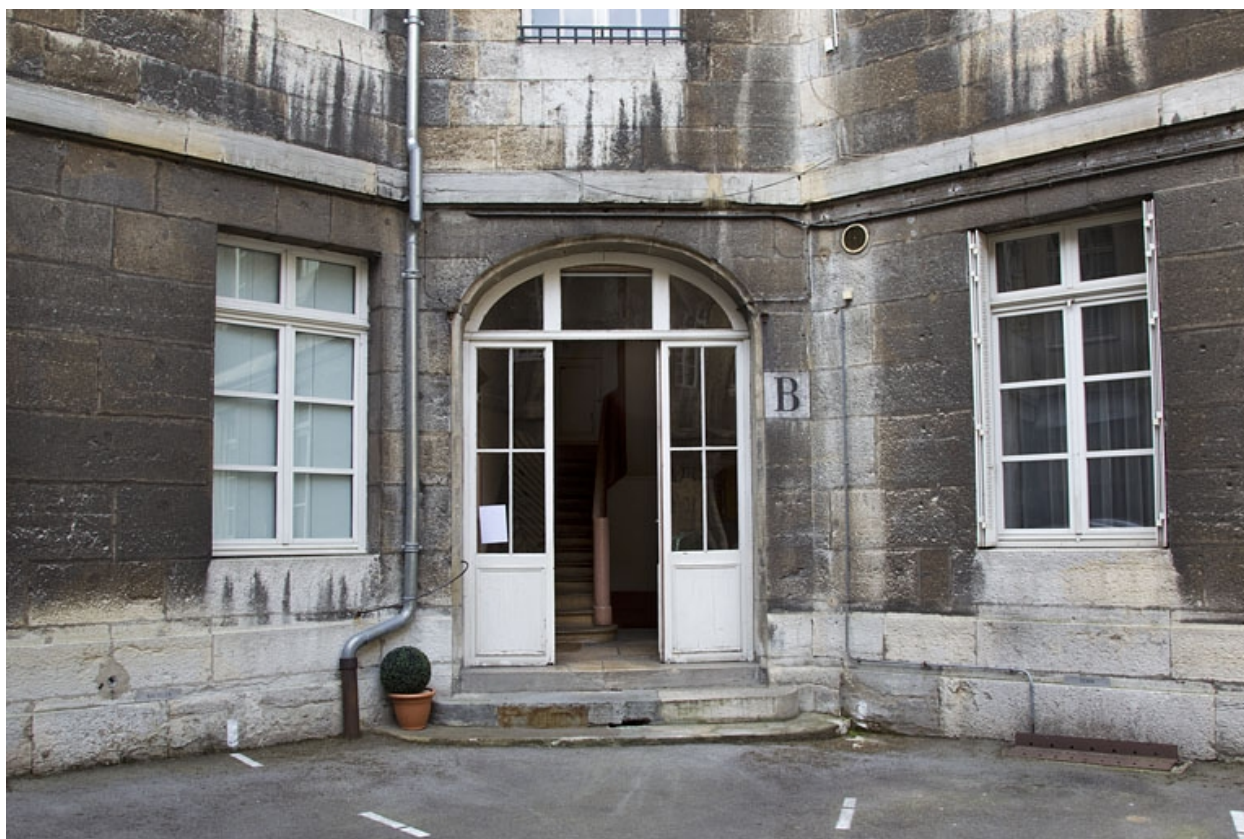
Logis principal : entrée secondaire de l'aile droite.
