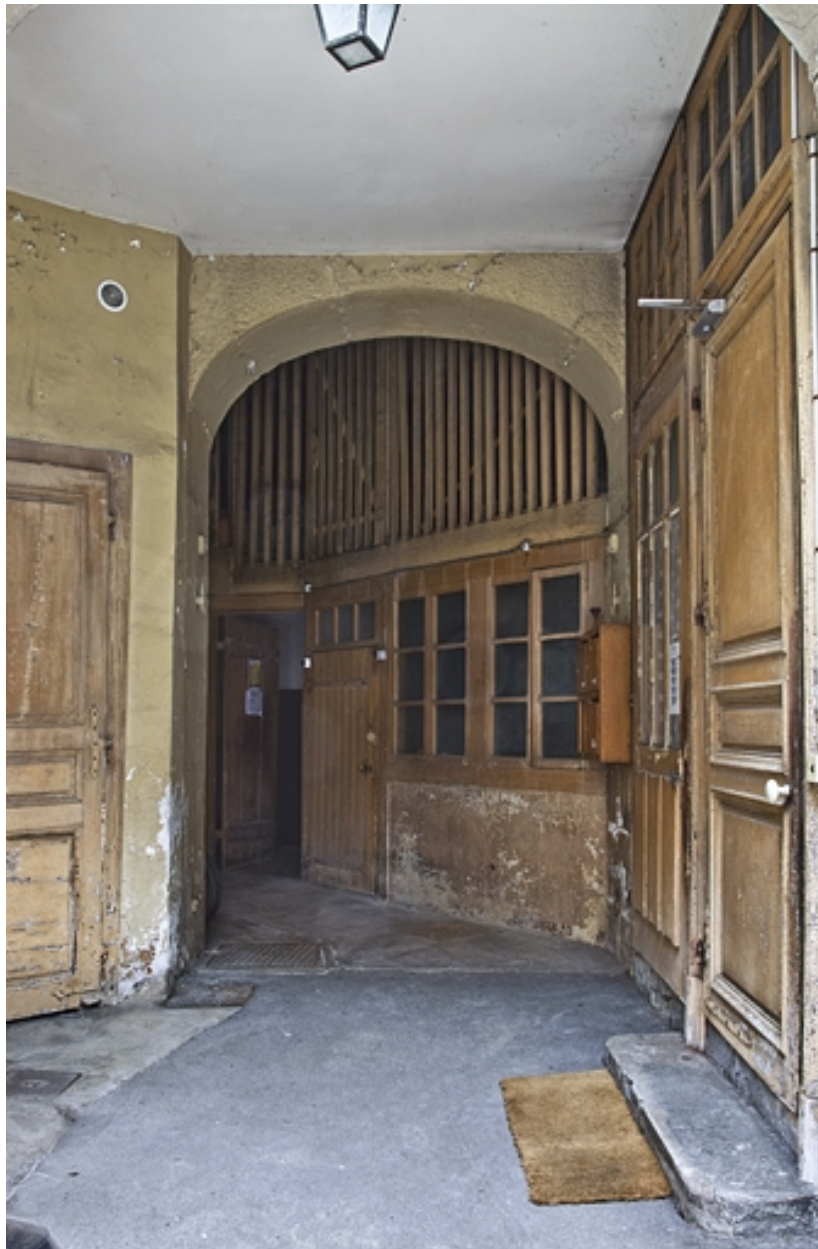
Vue d'ensemble de l'entrée de l'écurie.
