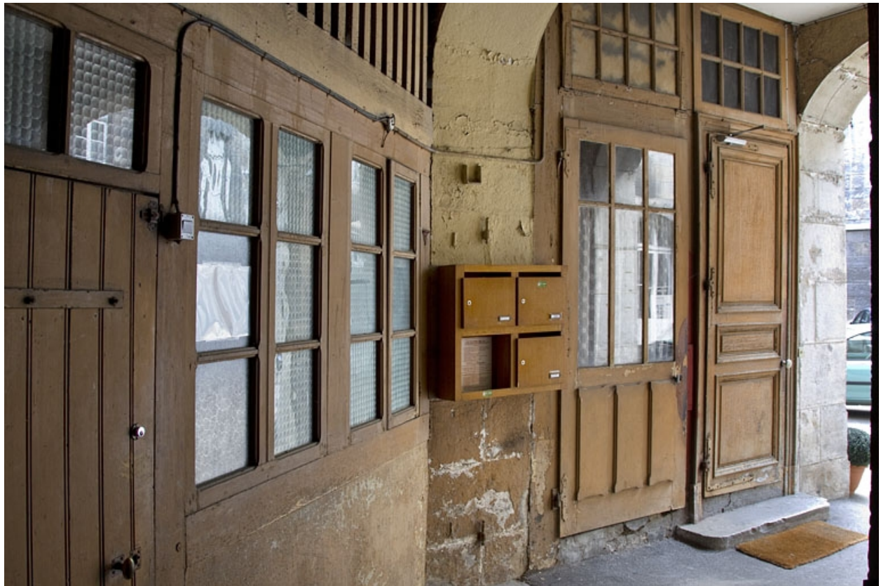
Ecurie : vue de la façade extérieure.
