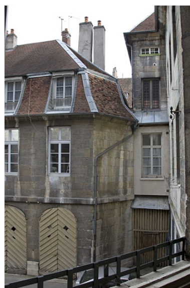
Logis principal : détail du bûcher. Phot. Yves Sancey IVR43_20112500736NUC2A
