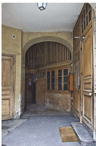
Vue d'ensemble de l'entrée de l'écurie. Phot. Yves Sancey IVR43_20112500731NUC2A
