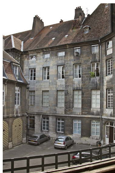
Logis principal : aile droite sur cour. Phot. Yves Sancey IVR43_20112500730NUC2A
