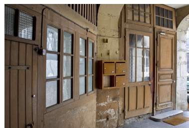
Ecurie : vue de la façade extérieure. Phot. Yves Sancey IVR43_20112500733NUC2A
