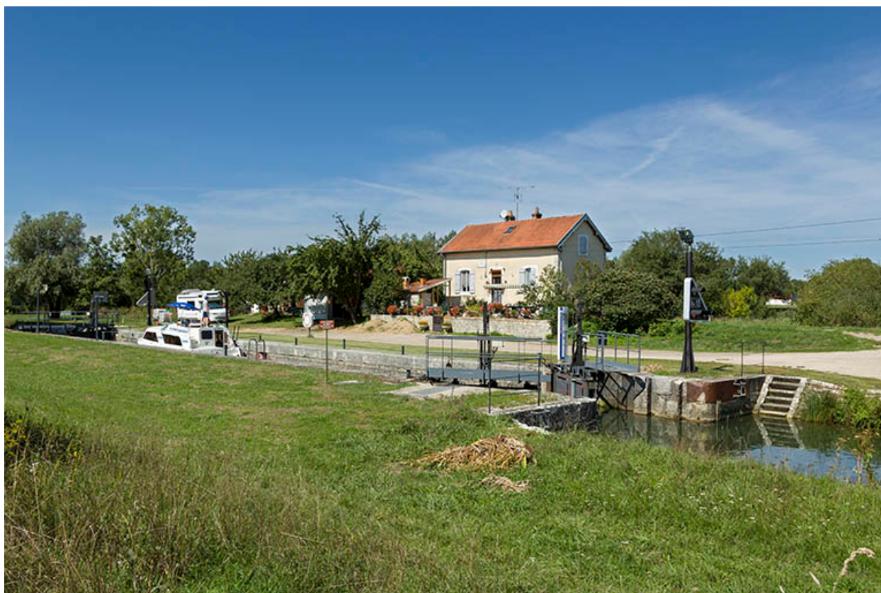
Vue générale du site d'écluse.
