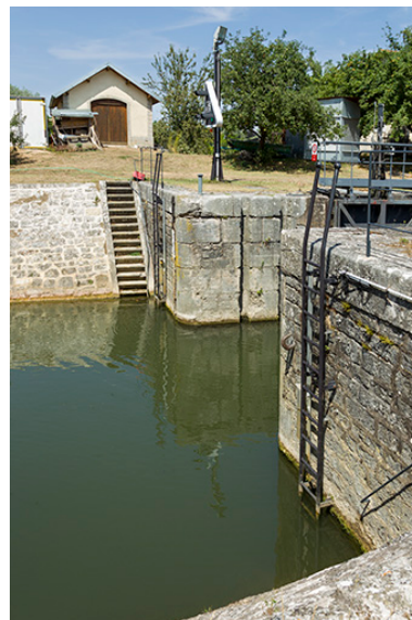
Vue sur la tête de l'écluse. Phot. Sonia Dourlot IVR43_20157000866NUC2A
