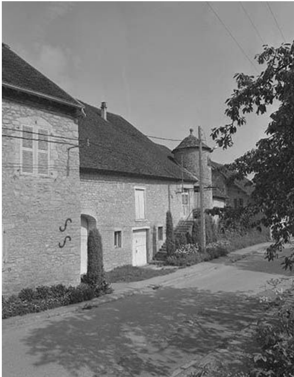
Façade sur rue, partie gauche.
