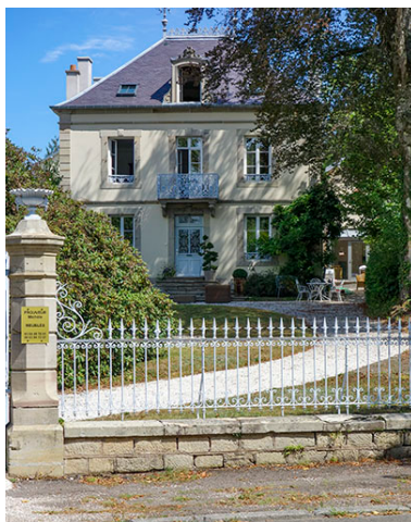
Vue depuis la rue. Phot. Fabien Dufoulon IVR43_20227000319NUC4A
